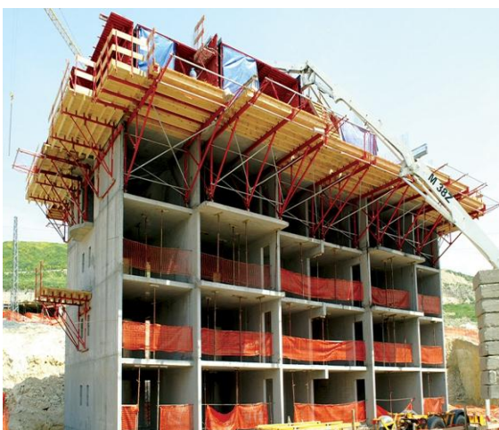
Fig 6 : Passerelles de décoffrage
