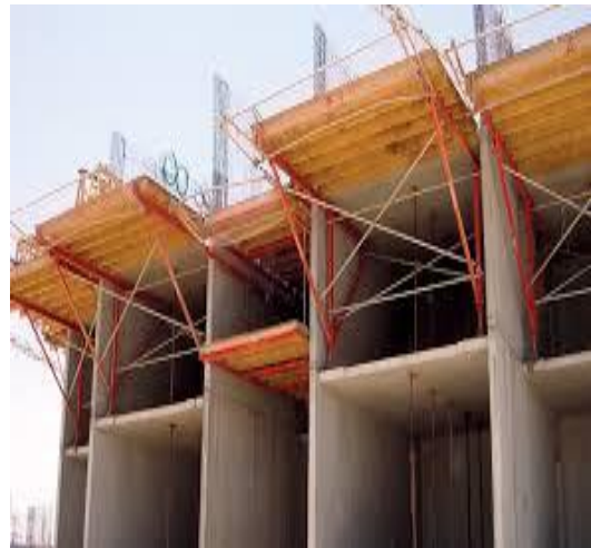
Fig 6 : Passerelles de décoffrage
