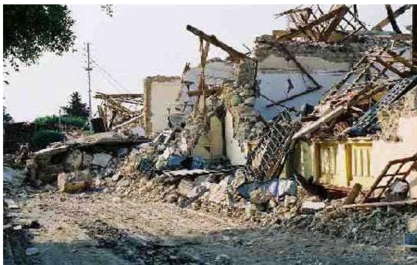
Photo 10 : construction en ferme en bois et murs épais ( ZEMMOURI )
