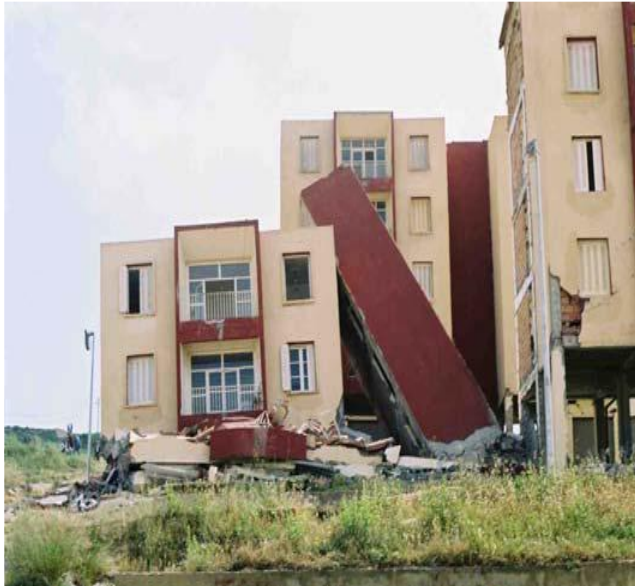
Photo 5 : transparence du réez de chaussée (DELLYS) Croquis 1
