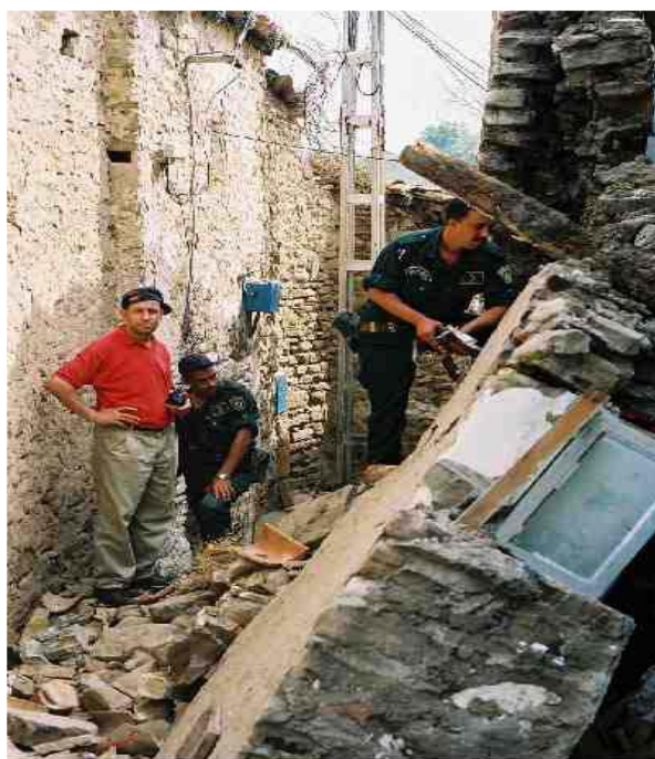
Photo 8 : les murs d'origine moellon ( DELLYS )
