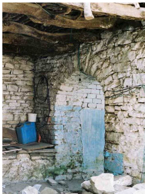
Photo 7 : les plancher en tronc d'arbre et les arcs faibles ( DELLYS )
