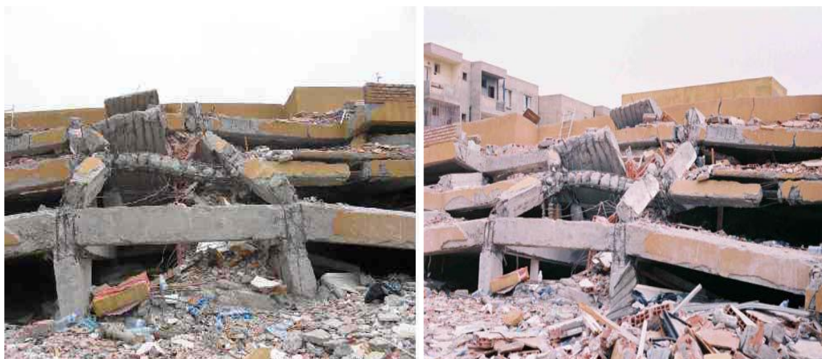
Photo 4 : l'effondrement totale en mille feuilles ( BOUMERDES )
