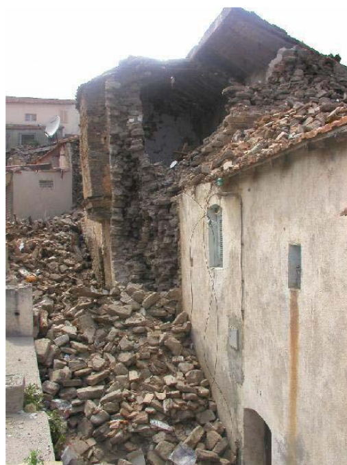
Photo 7 : les plancher en tronc d'arbre et les arcs faibles ( DELLYS )
