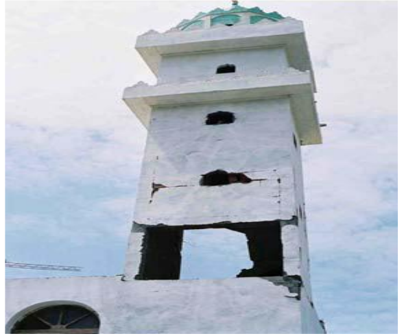
Photo13 : l'endommagement des minarets (CAP GINET)
