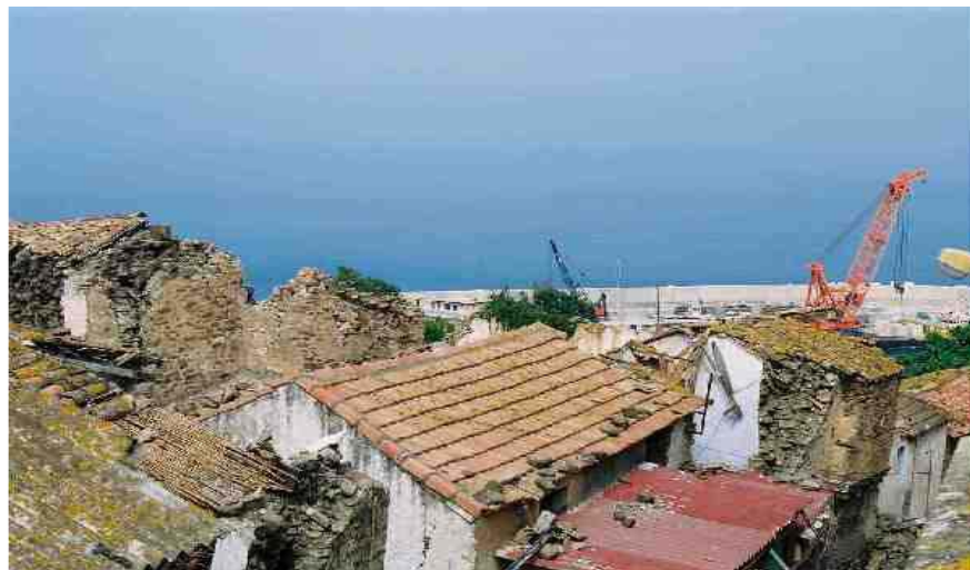
Photo 6 : planchers de faible intégrité (DELLYS)
