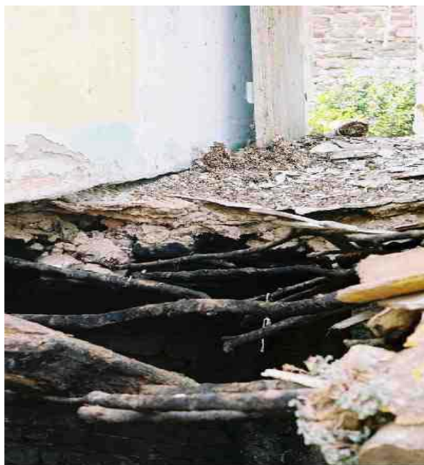
Photo 7 : les plancher en tronc d'arbre et les arcs faibles ( DELLYS )
