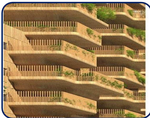
Figure 92 : des brises soleil en bois.
