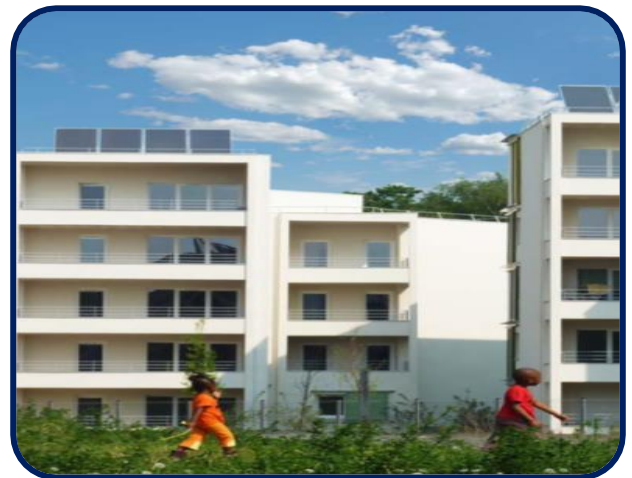
Façade 74 : façade sud.
