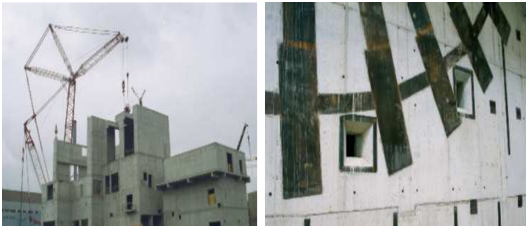
Fig. I.6 : Bâtiment industriel complexe, réalisé en BAP coulé sur chantier [FEBELCEM, 2005]
