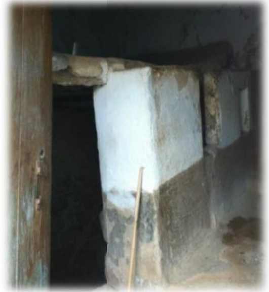
Figure 14: vue sur Tadekkwant. Village Felden, Akbou. (Source : auteurs, 2016)
