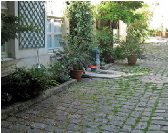
Pieds d'immeubles plantés, cour pavée perméable, Paris 4 e
