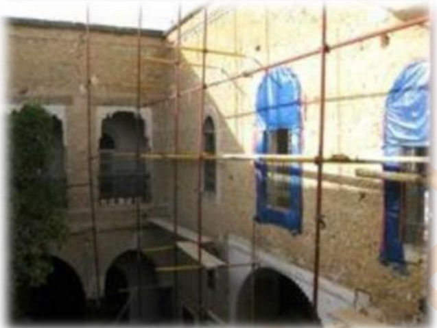
Photo 04 Travaux de dépose des zelliges muraux
