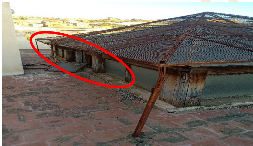
Photo 92: état actuel de la couverture du patio
