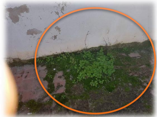
Photos 58 et 59 : Prolifération des plantes envahissantes dans le plancher de bâtiment.
