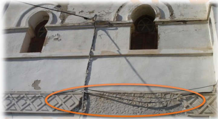
Photo 85 : Installation de câbles électriques au niveau de la façade de la maison d'El-Kaid après restauration 138 .
