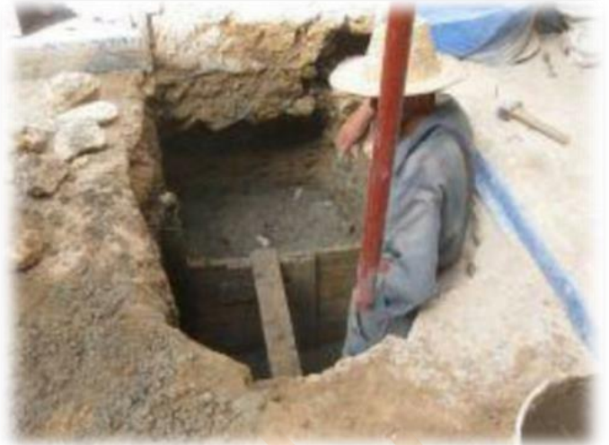
Photo 03: Réfection des murs endommagés.
