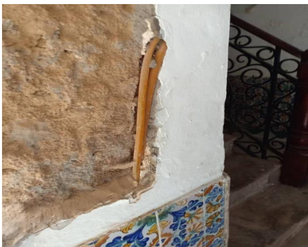
Photos 67 et 78 : passages des câbles électriques.
