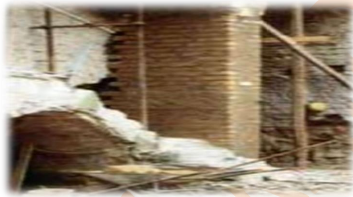
Photo 78 : Remplacement physique de la partie endommagée.
