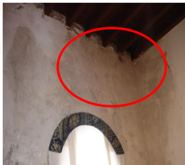
Photos 94 et 95 : Infiltration des eaux pluviales dans le bâtiment à cause de la cassure de L'emboîtement du collecteur d'eau pluviale encastré dans le mûr
