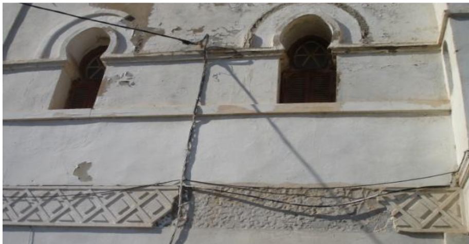
Photo 98 : Installation de câbles électriques au niveau de la façade de la maison d'ElKaied après restauration.
