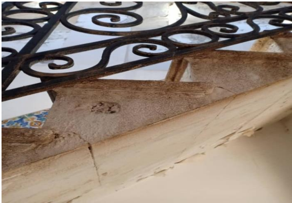
Photos 75 et 76: les fissures au niveau de l'escalier.
