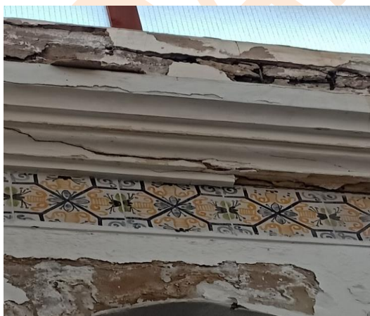
Photos 61 et 62 : La fissuration et l'effondrement de la corniche.
