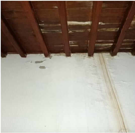
Photos 63 et 64 : La saturation des lattes en bois.
