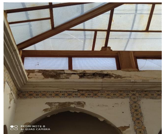
Photos 61 et 62 : La fissuration et l'effondrement de la corniche.
