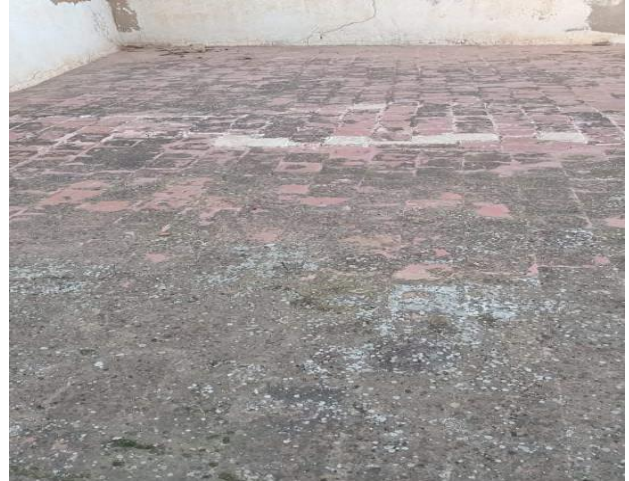
Photo 96 et 97 : Revêtement de sol existant gonflé et dégradé
