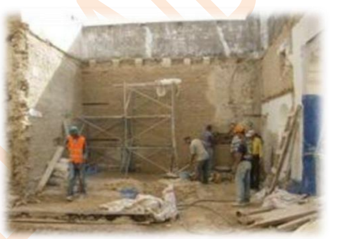
Photo 05: Travaux de décapage des murs.
