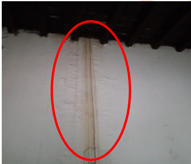
Photos 94 et 95 : Infiltration des eaux pluviales dans le bâtiment à cause de la cassure de L'emboîtement du collecteur d'eau pluviale encastré dans le mûr
