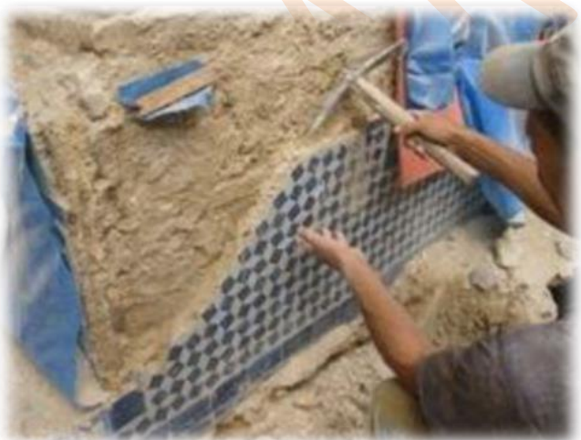
Photo 04 Travaux de dépose des zelliges muraux
