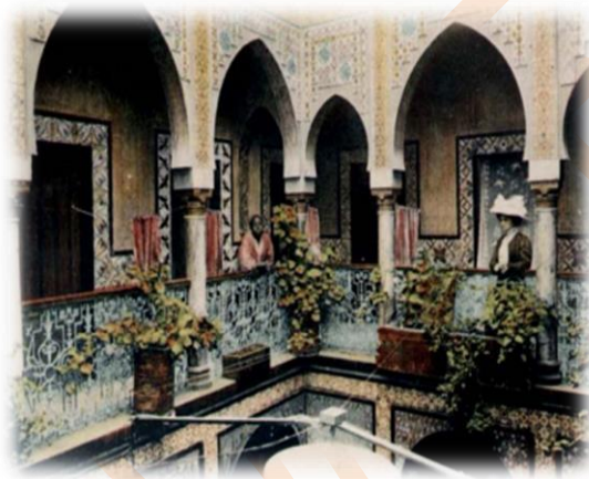
Photo 46: Vue d'intérieure de DAR ELKAID hier.
