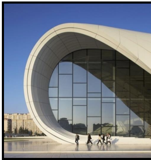
Figure 35 : la façade du centre.
