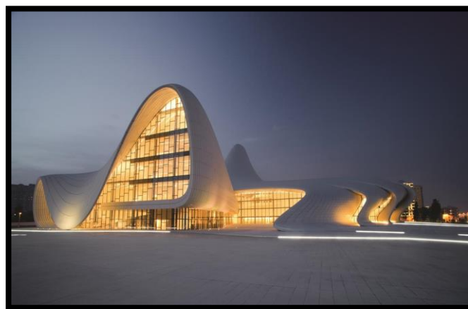
Figure 39 : l'éclairage à l'intérieur pendant la nuit.
