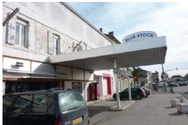
Démolition partielle : auvent
