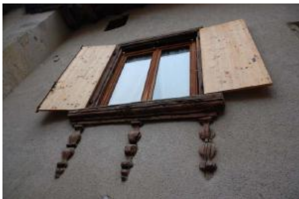
Élément particulier à restaurer et restituer Appuis et éléments sculptés 15/16eme s.
