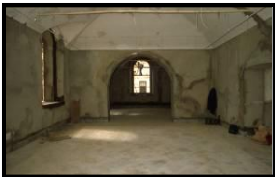
Fig.41 : Dar Lasram avant la restauration
