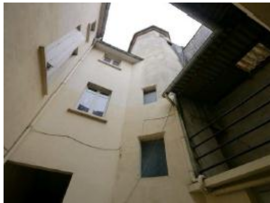
Ouvrage remarquable : tour d'escalier polygonale
