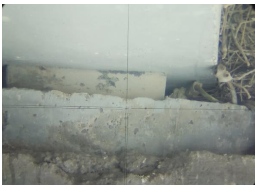
Vue d'un appareil d'appui en élastomère fretté sous une poutre principale en rive sur culée côté Oran
