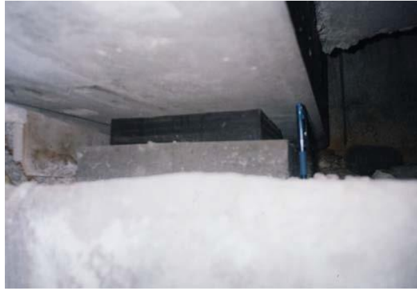
Figure 5: Appareil d'appui sous une poutre.
