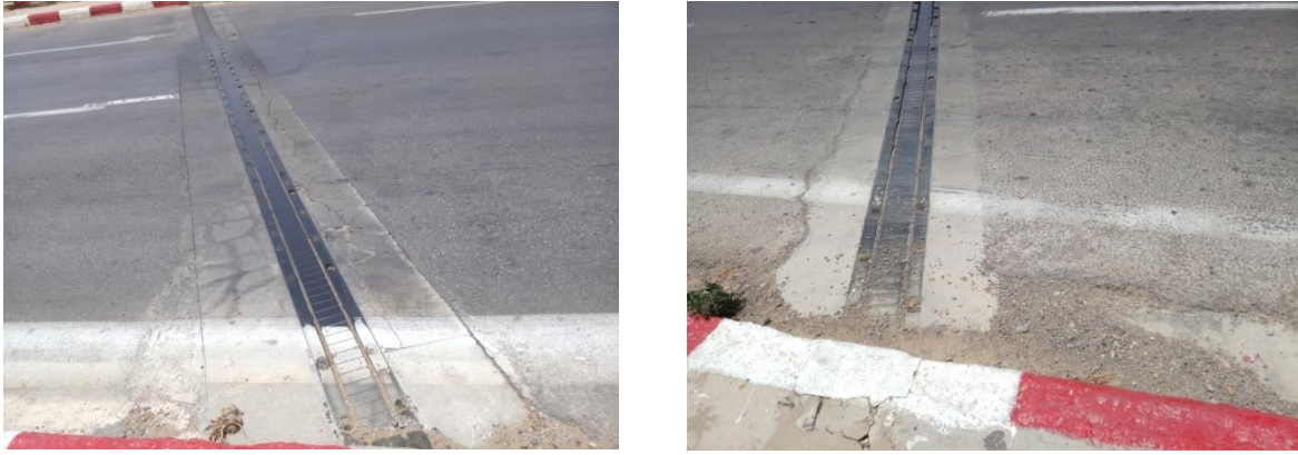
Figure 11: Vue de détail du joint de chaussée sur culée
