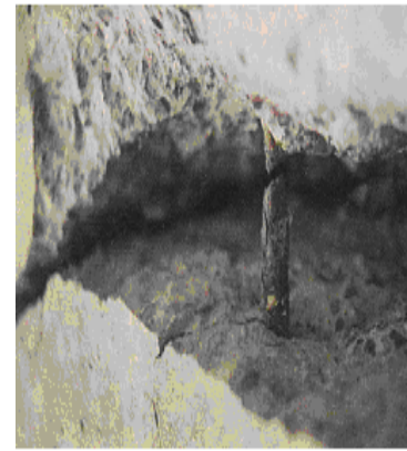
c) Rupture d'un acier passif [54]
