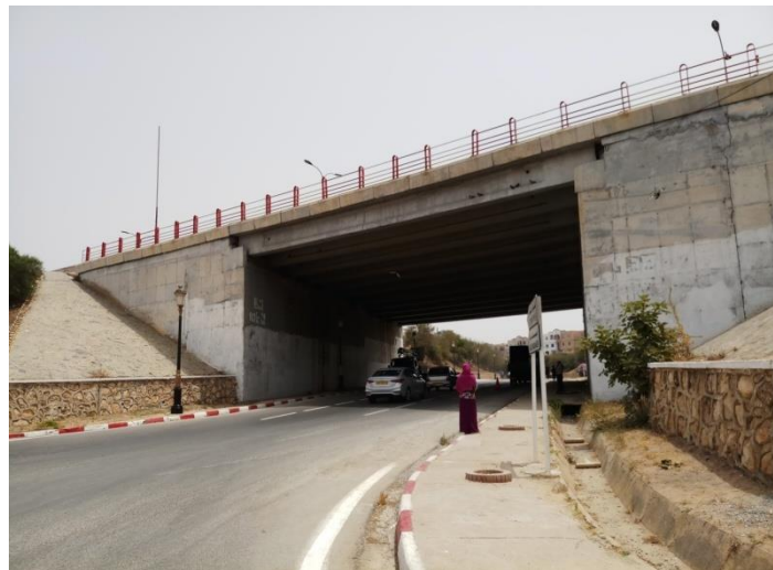
Figure 14: Vue sur les corniches côté localité de Stidia
