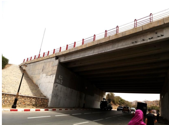
Figure 13: Vue sur les corniches côté localité de Stidia
