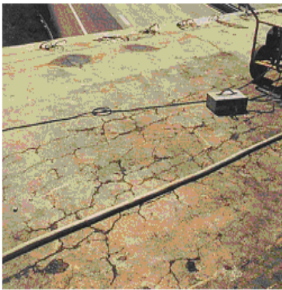
a) Tablier d'un pont [39]
