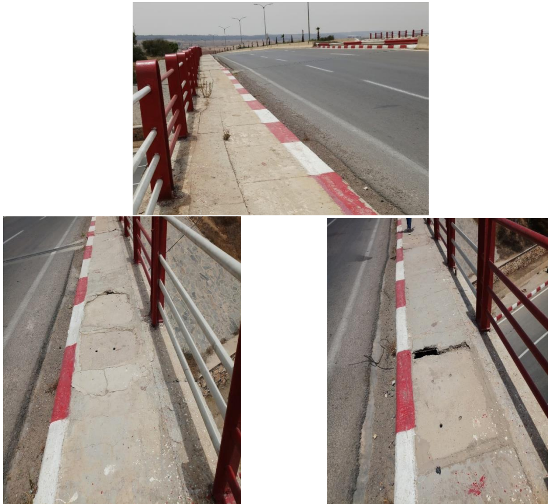
Figure 15: Vue de détail du trottoir en amont côté localité de Stidia
