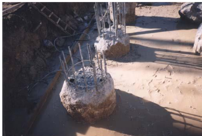
Figure 2: Tête des pieux en cours de recépage.[16]
