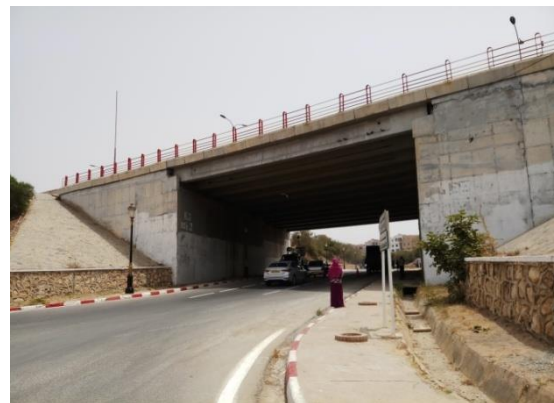
Vue de l'ouvrage en élévation côté Mostaganem.
