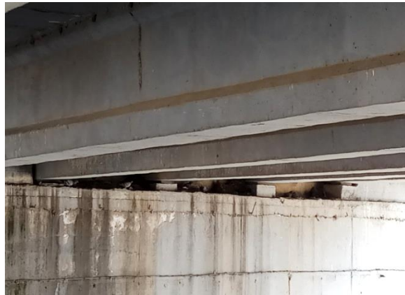
Vue générale des appareils d'appui sur sous des poutres principales en travée sur culée
