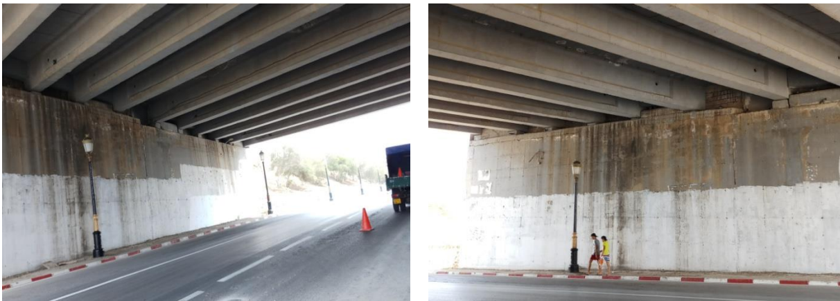
Figure 3 : Vue en élévation du mur frontal de la culée côté Mostaganem
