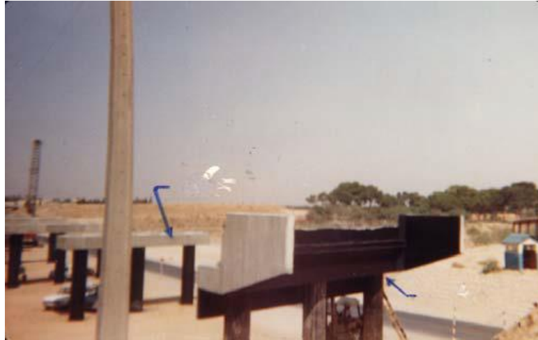
Figure 3: Appuis du pont. [16]
