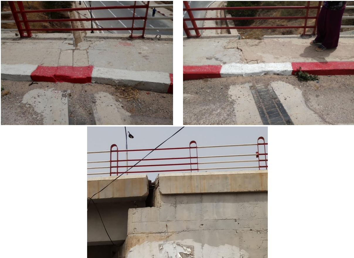
Figure 12: Vue de détail au droit de la jonction tablier-culée
