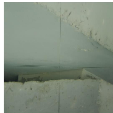
Vue d'un appareil d'appui en élastomère fretté sous une poutre principale en travée sur culée côté Oran
