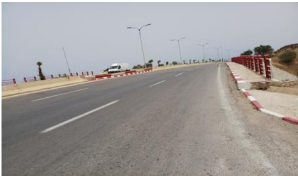
Vue générale de l'ouvrage
