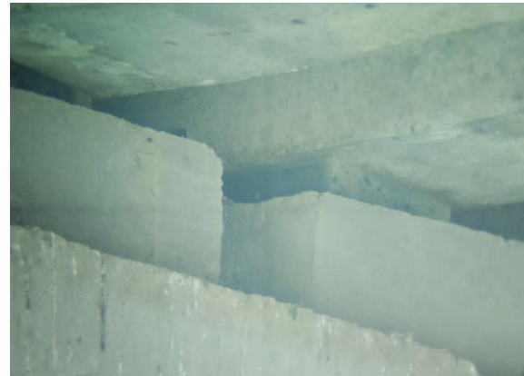
Vue de détail des appareils d'appui en élastomère fretté sous les poutres principales en travée sur culée côté Mostaganem
