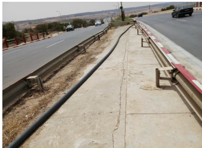
Figure 10: Vue de l'extérieur du point de jonction entre les deux tabliers côtés localité de Stidia et plage de Stidia
