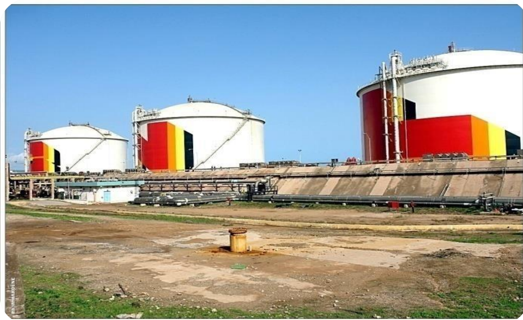
Fig I.04 : Zone de stockage et chargement du GNL
