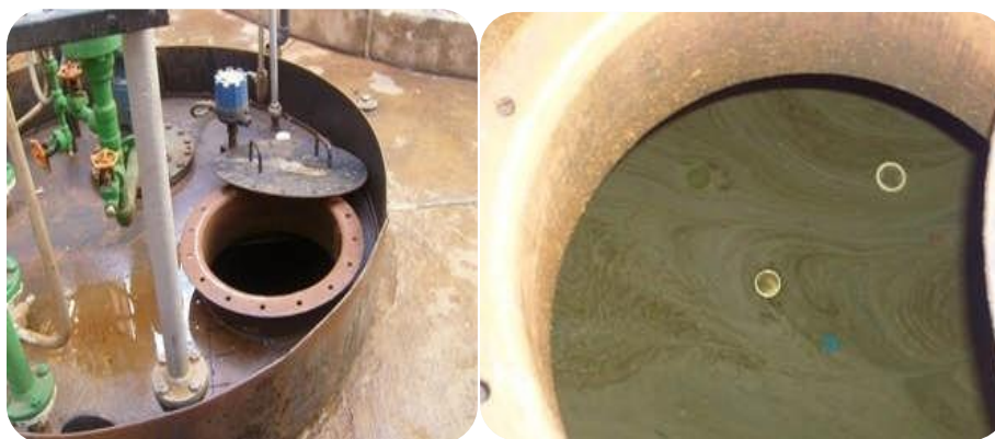
Fig V.03 : Contamination du puisard de MEA par l'huile
