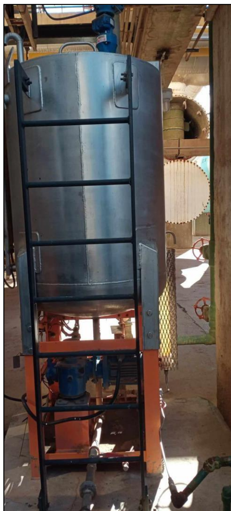
Fig III.03 : Pompe doseuse anti-mousse « 132-U »
