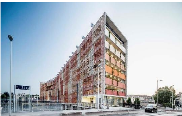
Fig. 66 : Parking réversible Saint-Roch - Source : archdaily.
