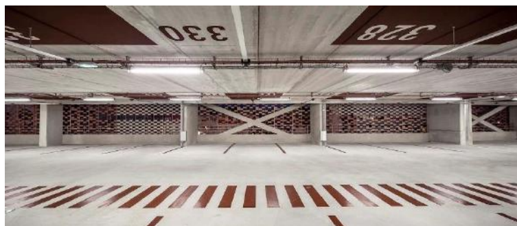
Fig. 80 : Parking réversible saint-roch - Source : archdaily.
