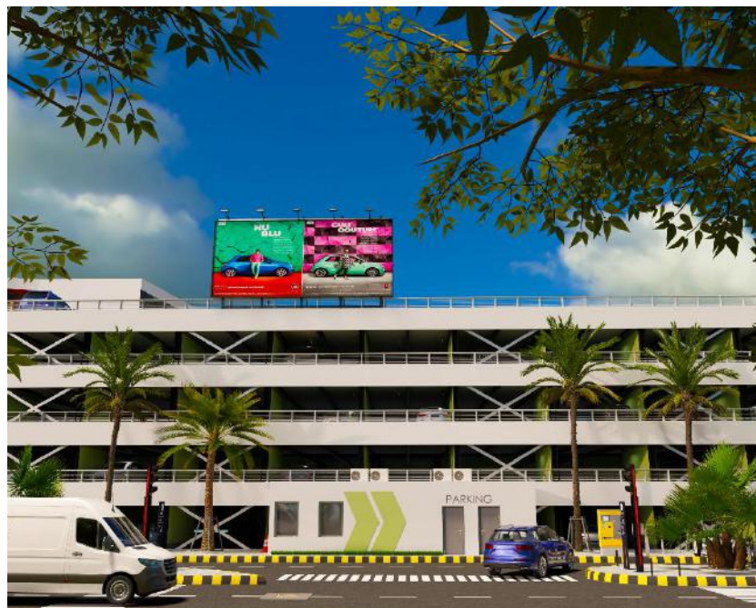
Fig. 95 : Vue de côté du parking à étages - Source : Auteur du mémoire.
