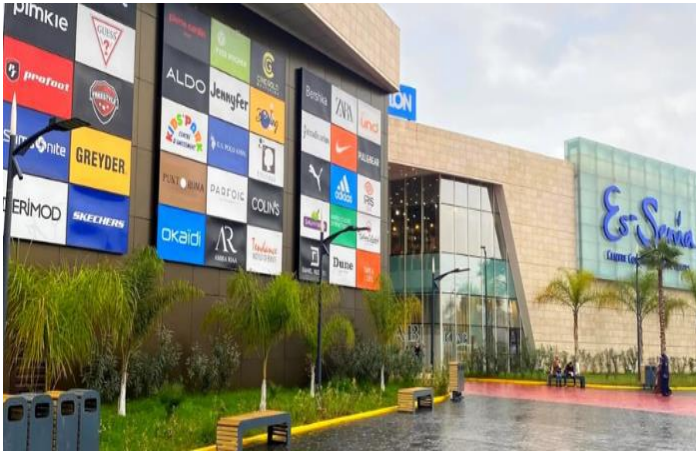
Fig. 64 : Centre commercial et loisir Es-Senia Oran - Source : google image.
