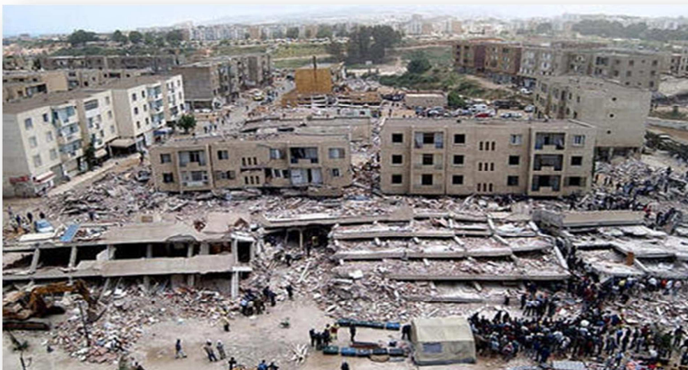
Fig.1.4 Dommages aux habitations suite au séisme de Zemmouri -Boumerdes 2003
