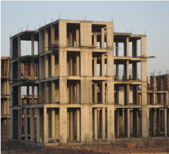
Fig.2.17 Bonne disposition et bonne exécution des voiles
