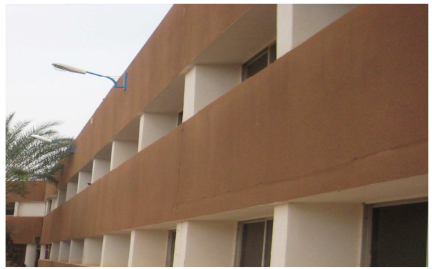
Fig.2.14Présence de poutres-allèges
