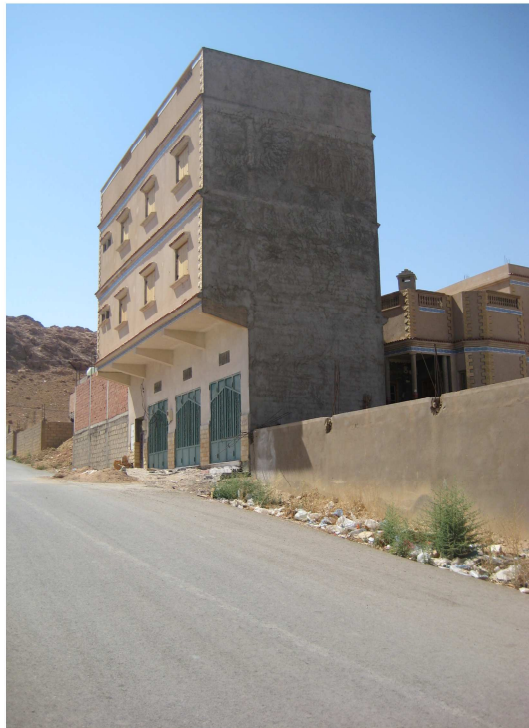
Fig.2.4 Mauvaise configuration de la forme en élévation 1
