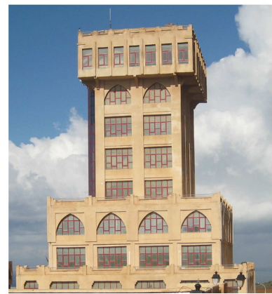
Fig.2.5 Mauvaise configuration de la forme en élévation 2
