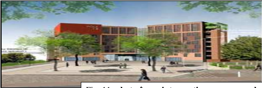
Fig. 11 :photo après intervention , source :web
