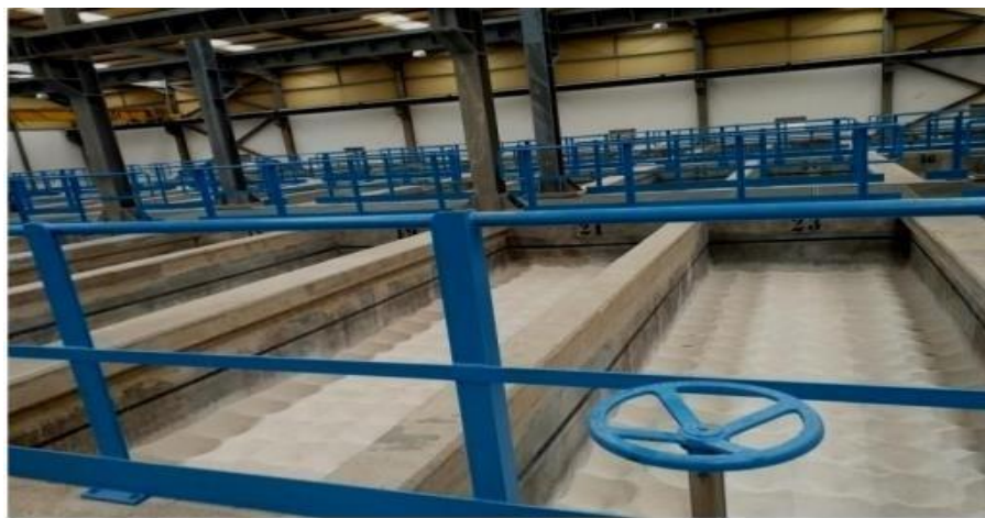
Figure II.13 : Les lits de calcite
