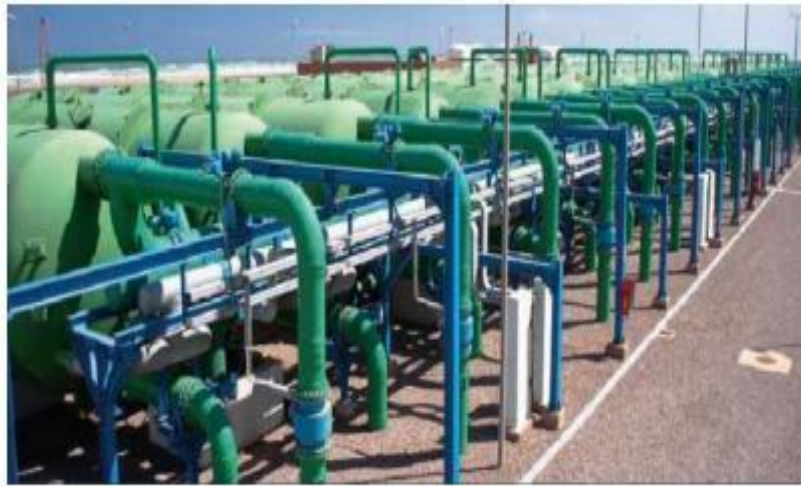
Figure II.6 : Filtres à sable et anthracite
