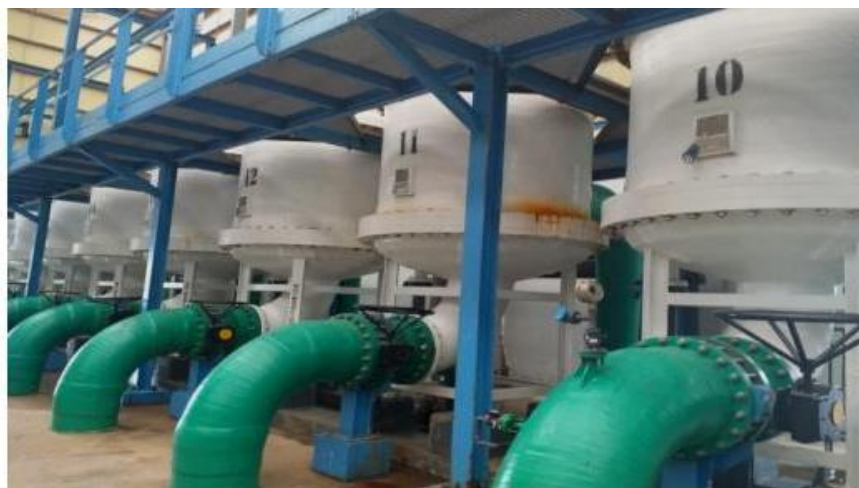
Figure II.8 : Filtres à cartouches
