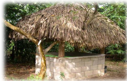
9/puits d'eau de source :
