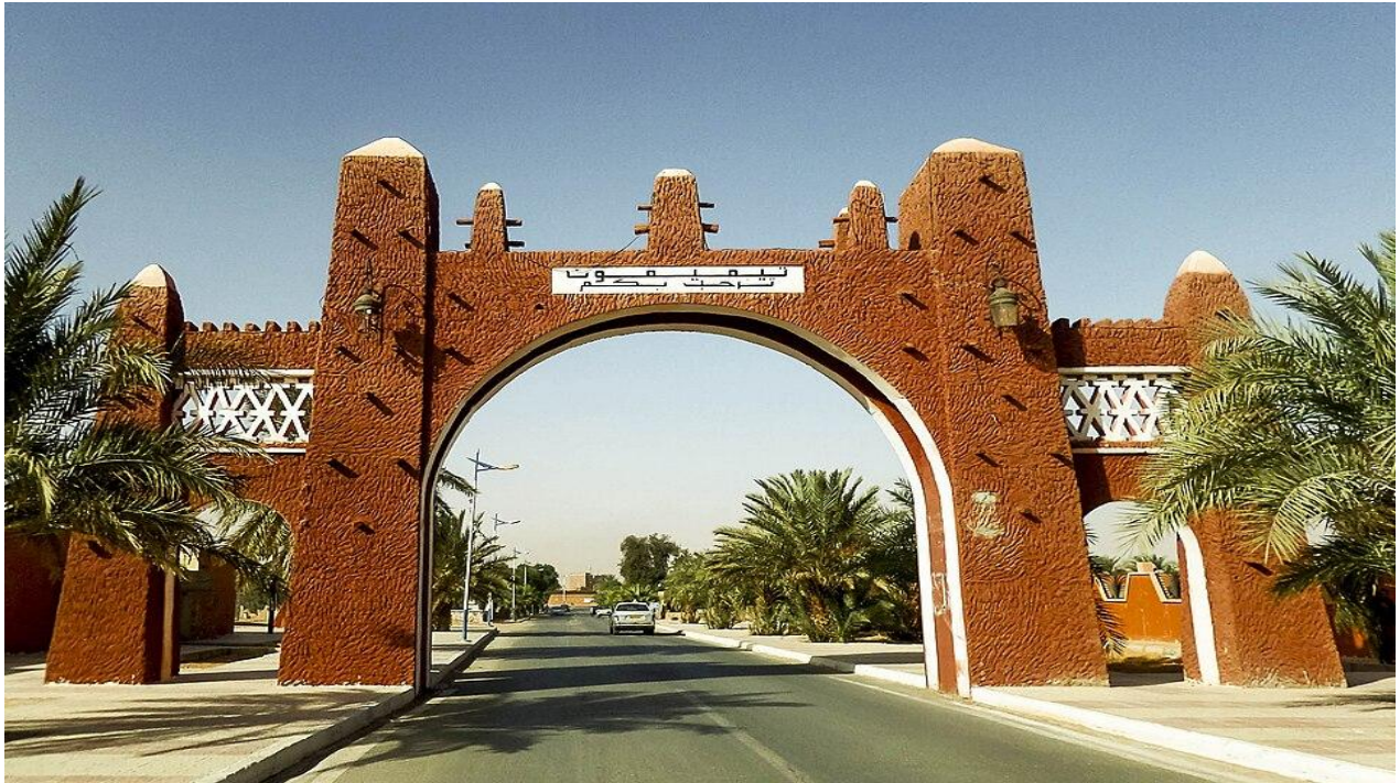
FIGURE.II. 3:Entrée de Timimoun
