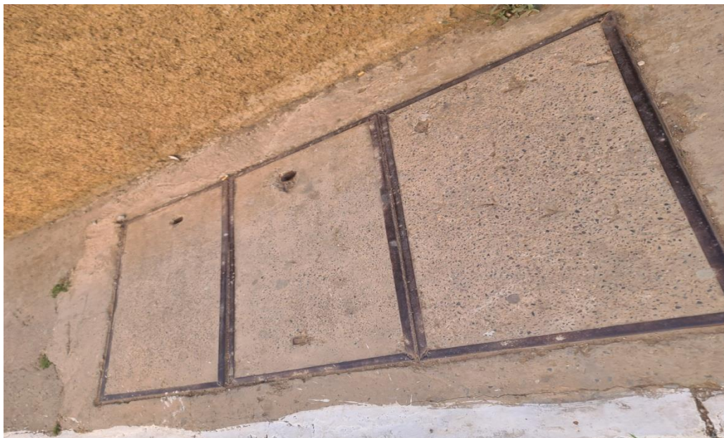
Figure III.9: Représentation de la chambre B1 [Photo réelle].
