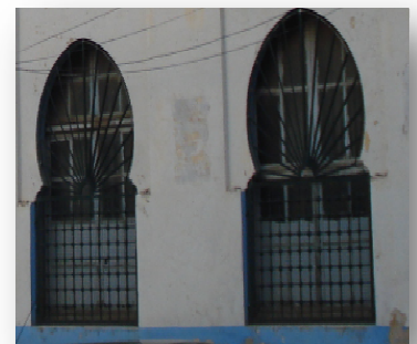
Figure 3-15: Fenêtre en outrepassé brisé Source : Photo prise par l'auteur.
