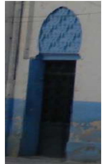
Figure 3-12: La porte secondaire. Source : Photo prise par l'auteur.
