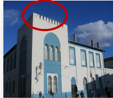
Figure 3-4 : Façade après la démolition de la coupole. Source : Photo prise par l'auteur.
