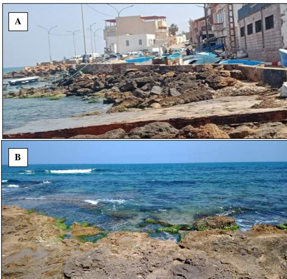
Figure 20 : Les deux stations 1 du site de Stidia, station1 (A) et station2 (B) (Présent travail).
