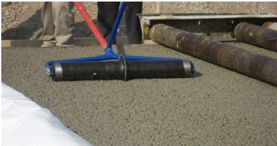
Figure ( I.12) : Pose des joints de dilatation
