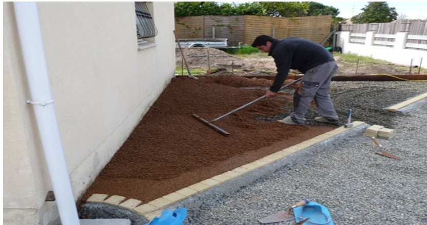
Figure ( I.13) : Etalage du béton drainant
