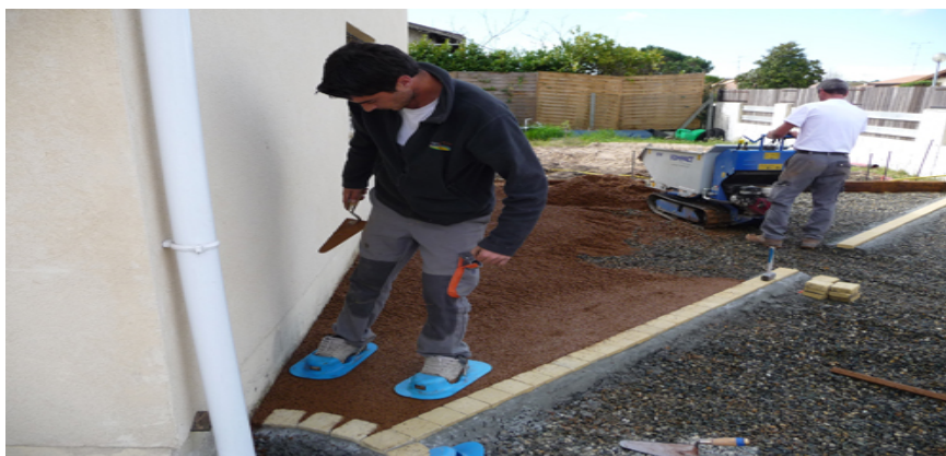
Figure ( I.14) : Damage du béton drainant.
