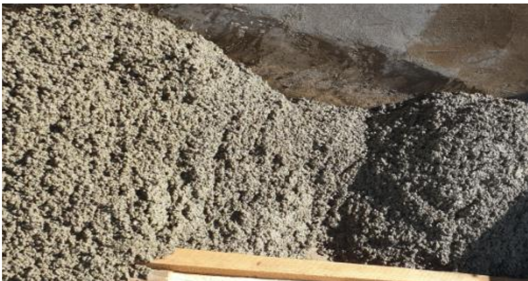
Figure ( II.23 ) : Réalisation du béton drainant.
