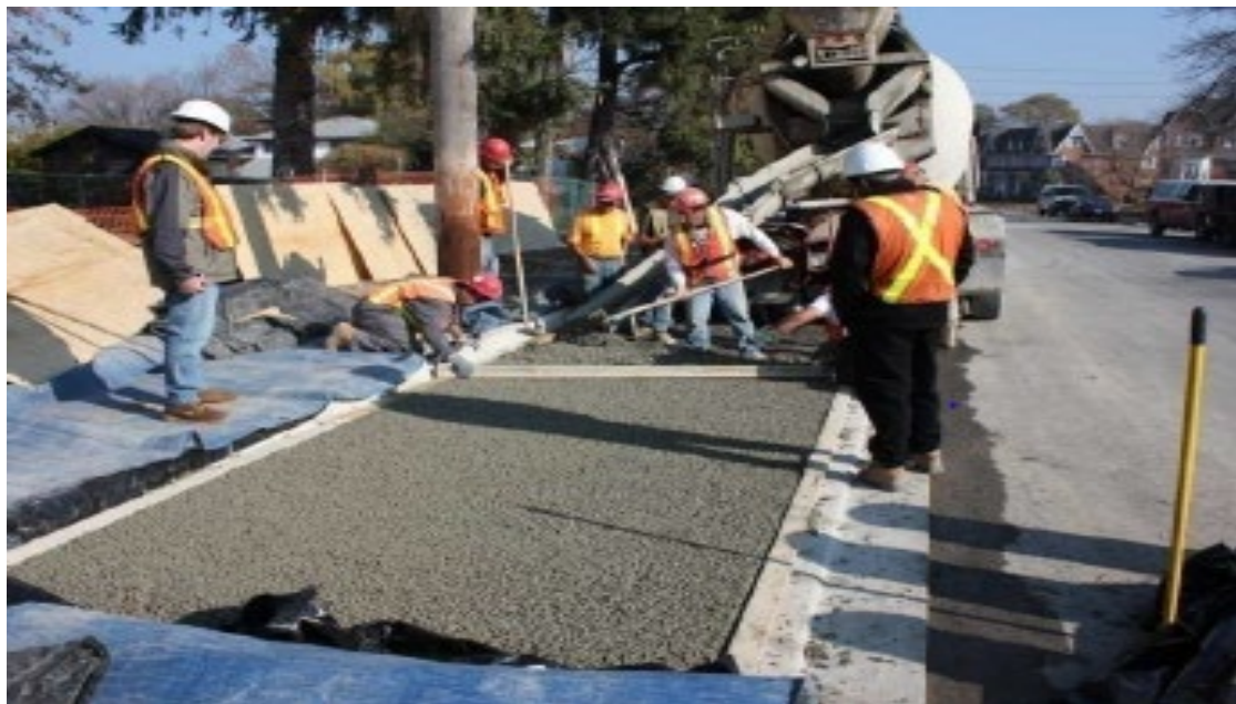
Figure ( I.10) Réalisation d'un trottoir au CANADA (ONTARIO 2008)
