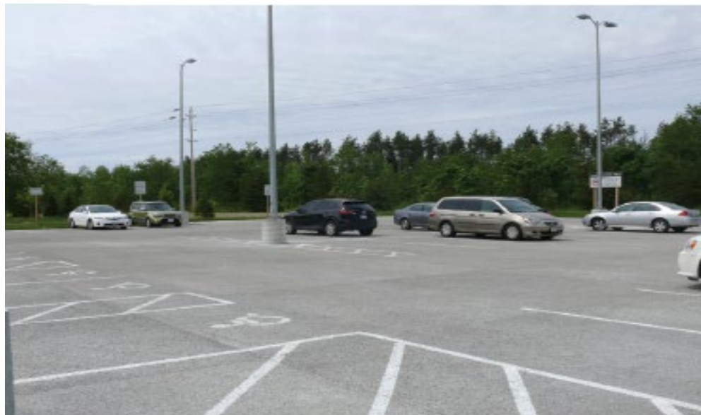
Figure ( I.9) : Réalisation d'un parking avec un béton drainant.
