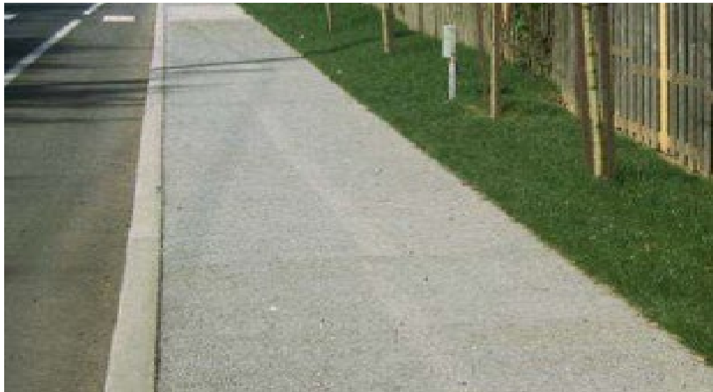
Figure ( I.8) : Trottoir en béton drainant.
