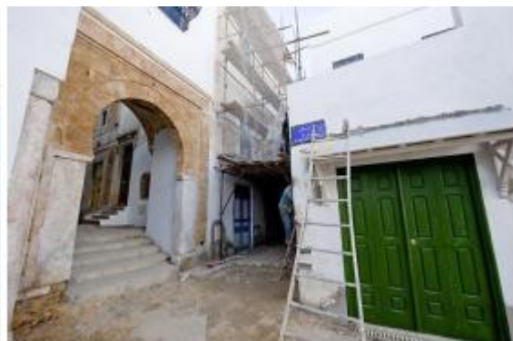
Quartier Hafsia en cours de travaux
