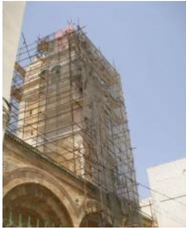
Restauration de la mosquée El Ksar
