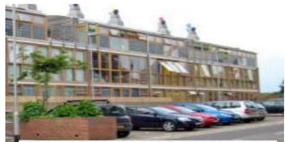
Figure19 : les parkings à BEDZED
