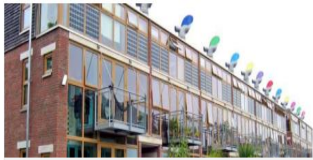
Figure 21: Les panneaux photovoltaïques
