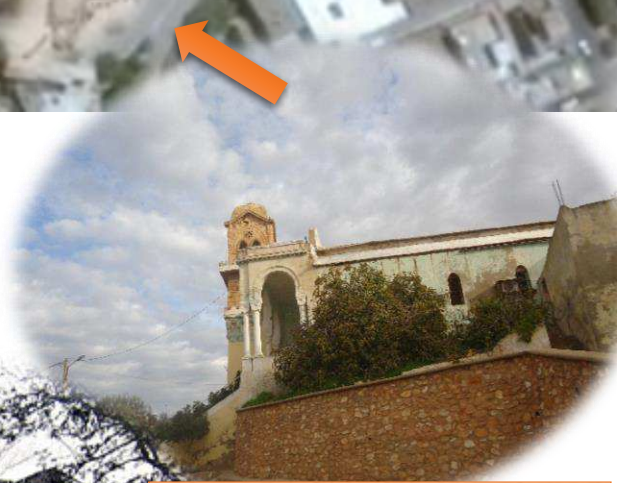
Vue prise sur la mosquée de Mazagran
