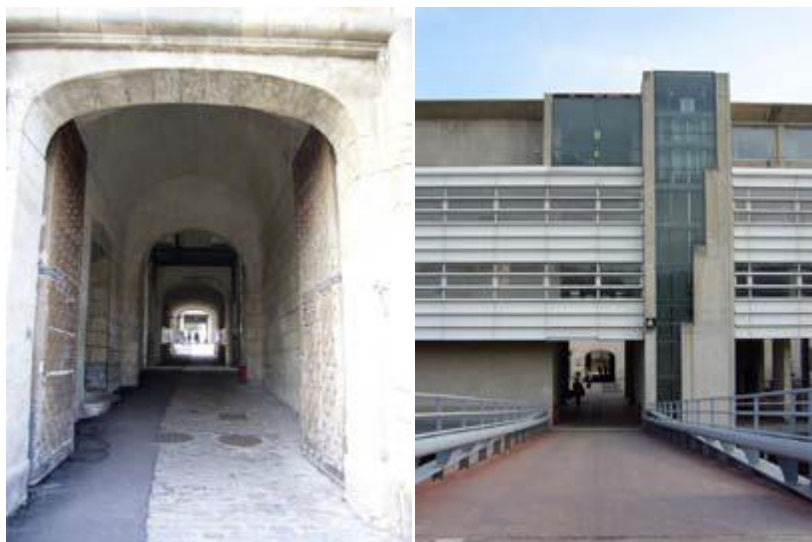
FIG 52 : Depuis la montée du Fort, accès à la cour d'honneur et, au-delà de la bibliothèque érigée sur pilotis, à l'esplanade nord.
