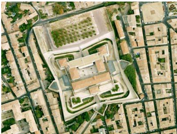
FIG 50 : Image Google Earth : au Sud-Ouest, accès piéton par la montée du Fort,
