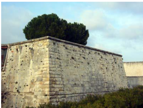
FIG 46 : Mise en œuvre « classique »
