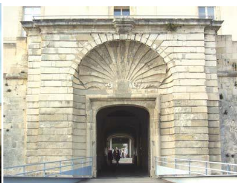
FIG 47 : La porte à la coquille, œuvre stéréotomique de JF Ferry
