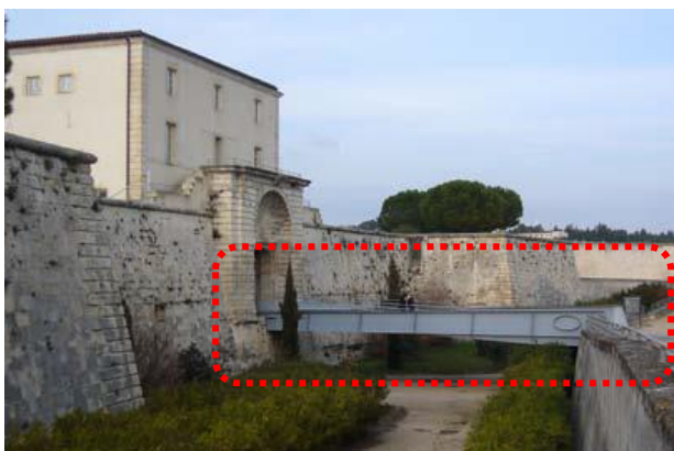
FIG 51 : La passerelle métallique franchit la douve et relie le corps de place au chemin couvert
