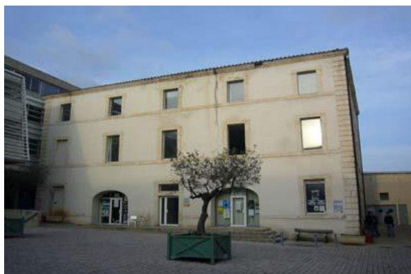
FIG 53: Ancien logement du major, réhabilité.
