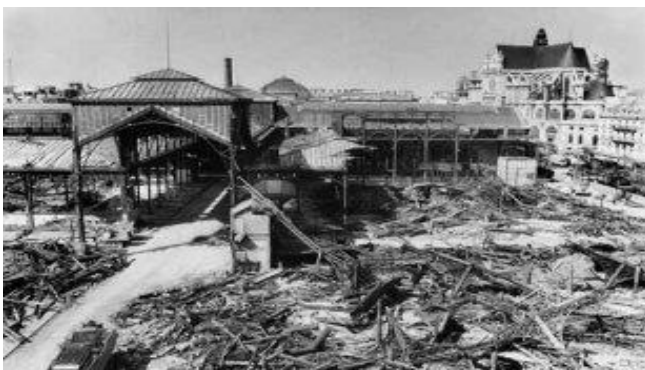
FIG 18 : Démolition des halls, démolition des pavillons Baltard.
