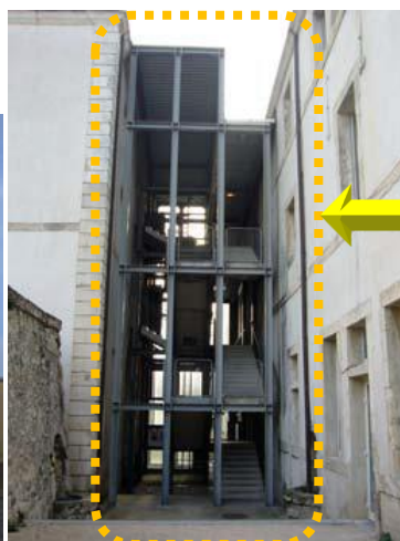
FIG 54 : Entre les bâtiments en pierre du corps de garde et de la caserne réaménagés, se glisse la structure métallique abritant les circulations verticales
