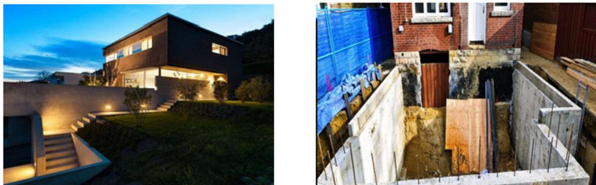
Figure 10: extension par excavation.
