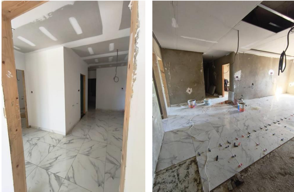
Figure IV.11 : État final des appartements — Finitions complètes : carrelage, peinture, faux-plafonds et menuiseries
