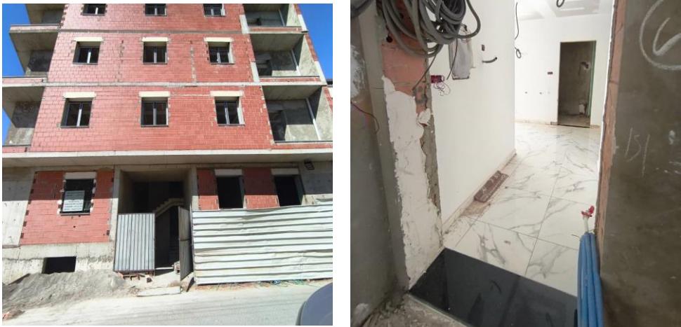
Figure IV.10 : Intérieur appartement — À gauche : Hall d'entrée avec carrelage marbre posé. À droite : Couloir de distribution — Finitions avancées
