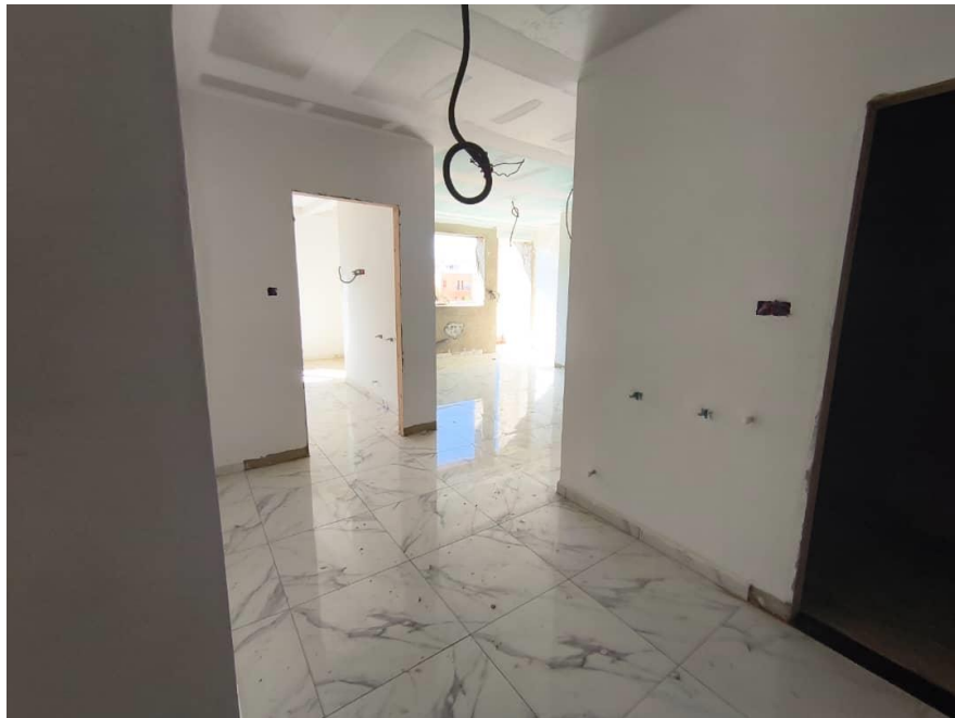
Figure IV.9 : Travaux d'électricité en cours — Conduits encastrés et câblage apparent — Enduit de dressage non peint
