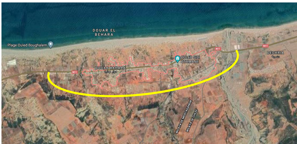
Figure N° 01 : tronçon de notre projet.
