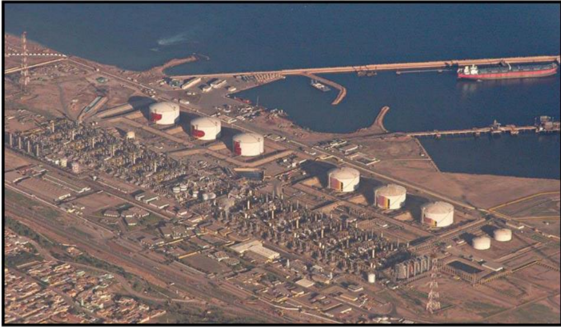
Figure 1.1 : Raffinerie d'Arzew vu Google MAPS
