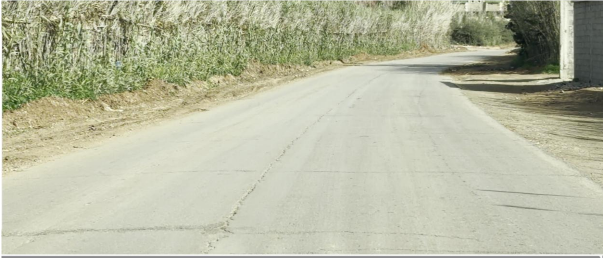
Figure I.2: fissure longitudinale
