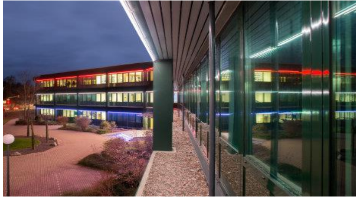
Figure 1. 7 : Gestion des infrastructures et bureaux [6]
