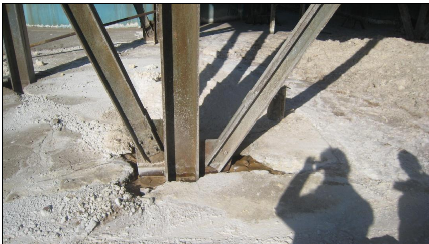
Figure2.11 : Tassements d'un fut de fondation
