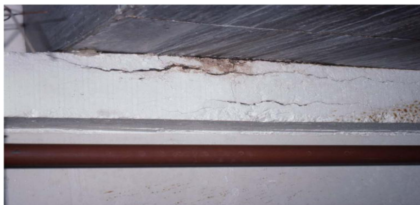
Figure 3.6: poutre support de réservoir
