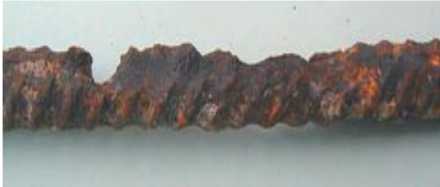
Figure 3.4 : Armature corrodée avec réduction de la section utile.
