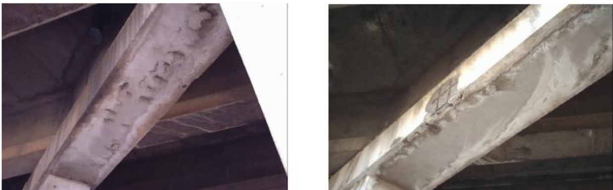
Figure 3.23: Insuffisance d'enrobage.
