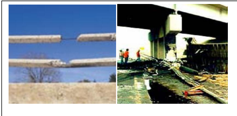
Figure 2.9: Choc sur une glissière de sécurité et une pile de pont
