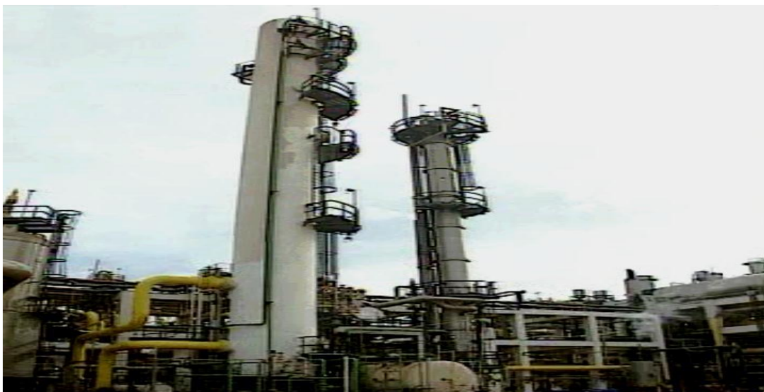
Figure 5 : Absorbeur et Régénérateur
