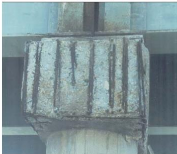
Figure II. 6 : Phénomène de corrosion des aciers (Haouara, S. 2014)
