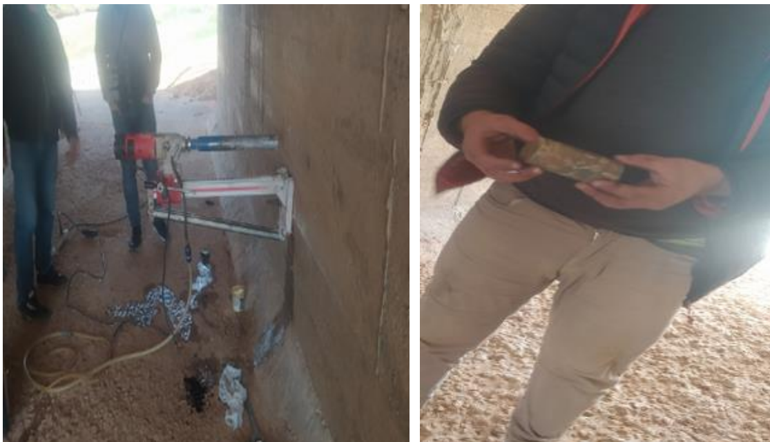
Figure III. 23 : Prélèvement des carottes de béton
