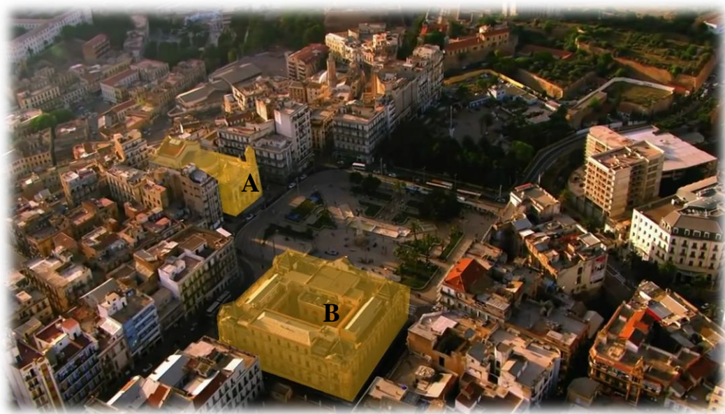
Figure 2.57: L'emplacement des deux batiments les plus représentants du style Napoléon III au centre ville d'Oran. Source : Yann Arthus-Bertrand avec mise en forme
