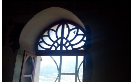
Figure 2.14: Porte fenêtre du balcon de la chambre de la favorite
