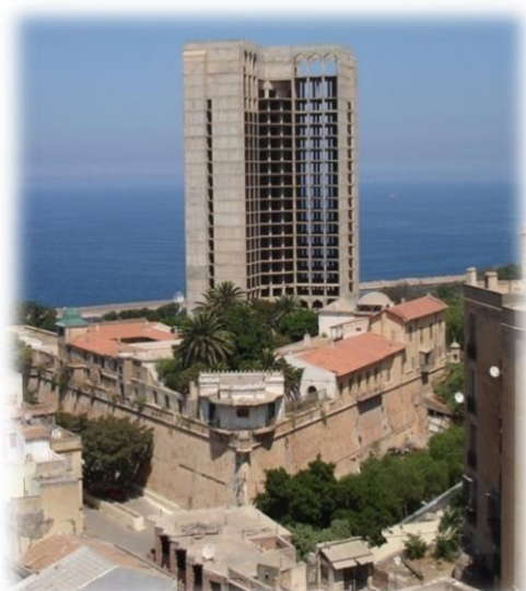
Figure 0.2: La tour du château neuf et le palais du Bey
