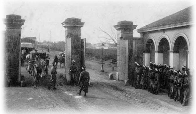
Figure 1.7 : Porte de Tlemcen (disparue). Source : Images anciennes de la ville d'Oran.
