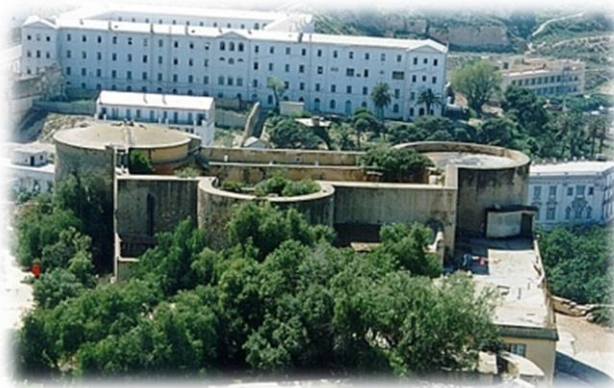
Figure 1.6: Vue sur Bordj el Ahmer. Source : Google images.
