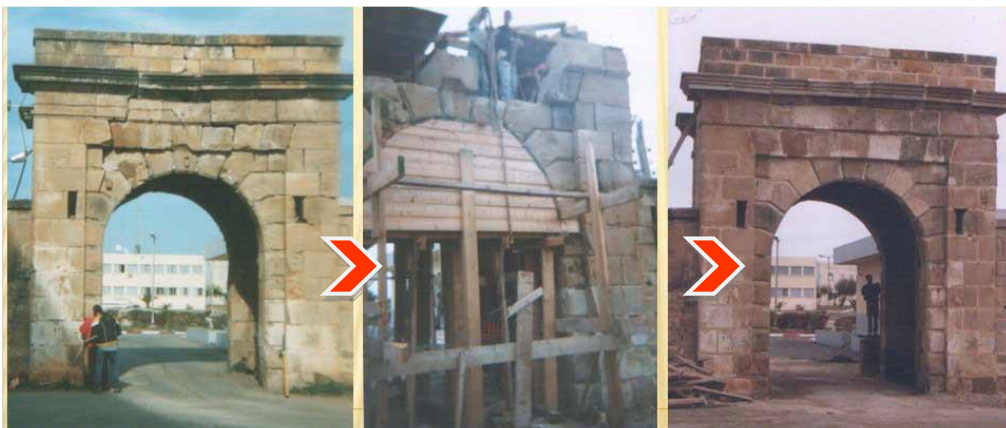
Figure 3.3 : Restauration de la porte de la citadelle (Jijel) sans modification de l'apparence
