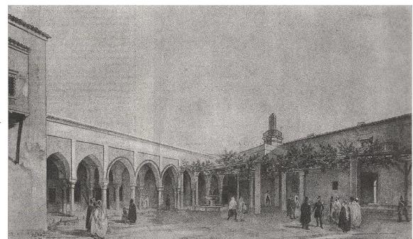
Figure 1.43 : Le palais du Bey durant l'époque Ottomane. Source : Aquarelle d'Oran ancienne
