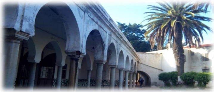
Figure 4.7 : Le Diwane du palais du Be, un péristyle formé des arcs outrepassés brisés
