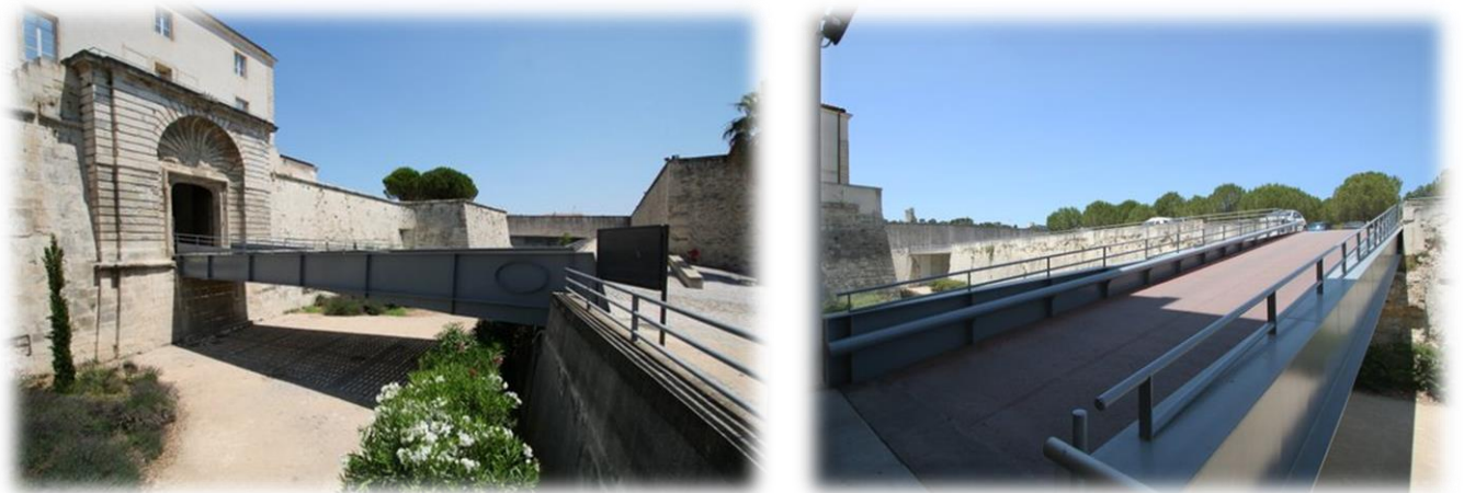
Figure 2.72 : Vue sur les passerelles. Source : Idem.
