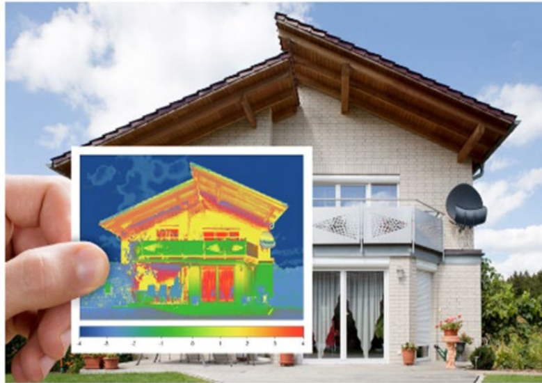
Figure 29. Thermographie d'une maison individuelle.
