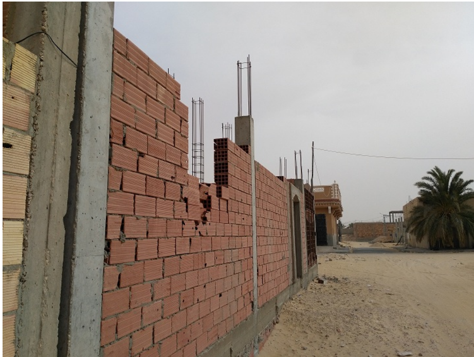
Figure 9. Murs extérieurs en brique non isolé
