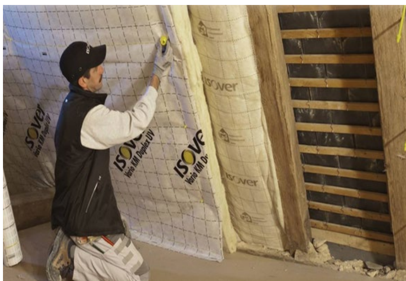
Figure 25. Membrane d'étanchéité pour l'isolation des combles.
