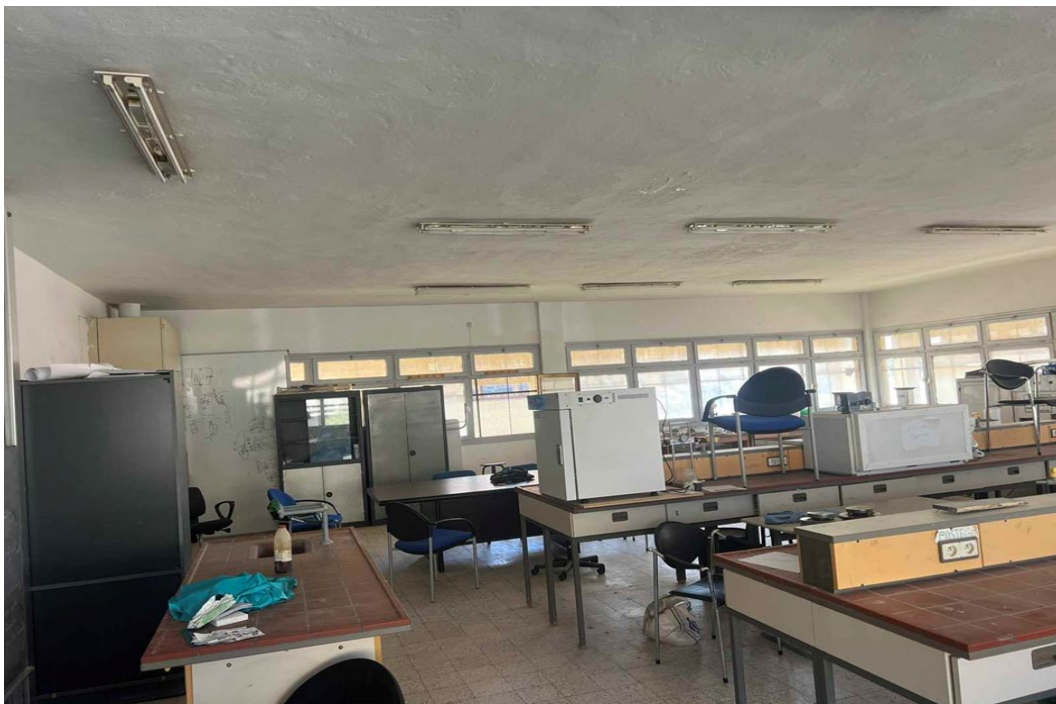
Figure 65. Vue intérieure du plancher haut du laboratoire.
