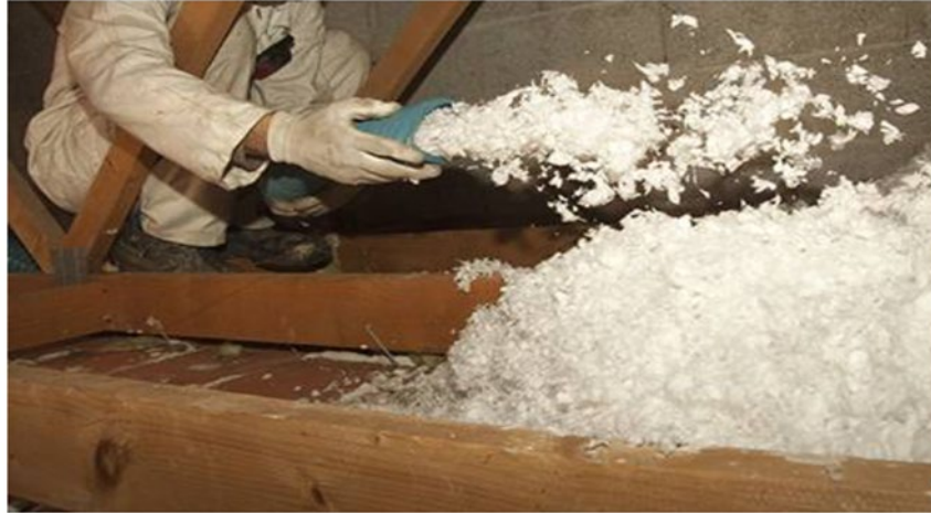
Figure 30. Isolation des combles perdus non-accessibles
