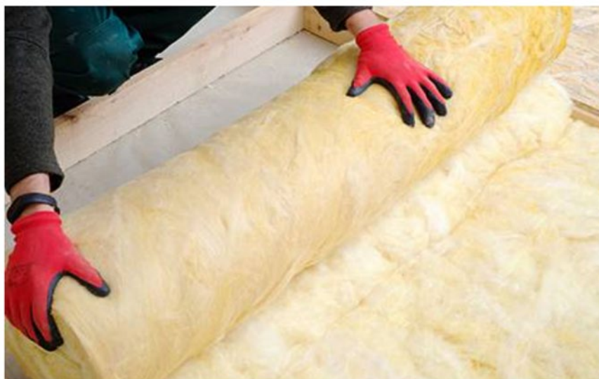
Figure 29. Isolation des combles perdus accessibles
