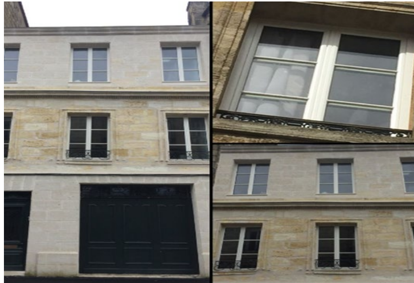
Figure 38. Remplacement des menuiseries sur un immeuble
