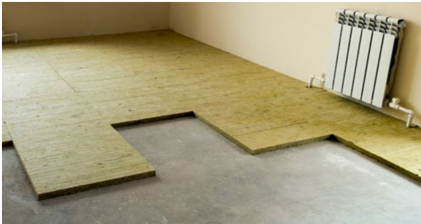
Figure 37. Isolation du plancher bas
