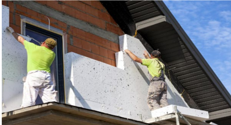
Figure 31. Isolation des murs par l'extérieur
