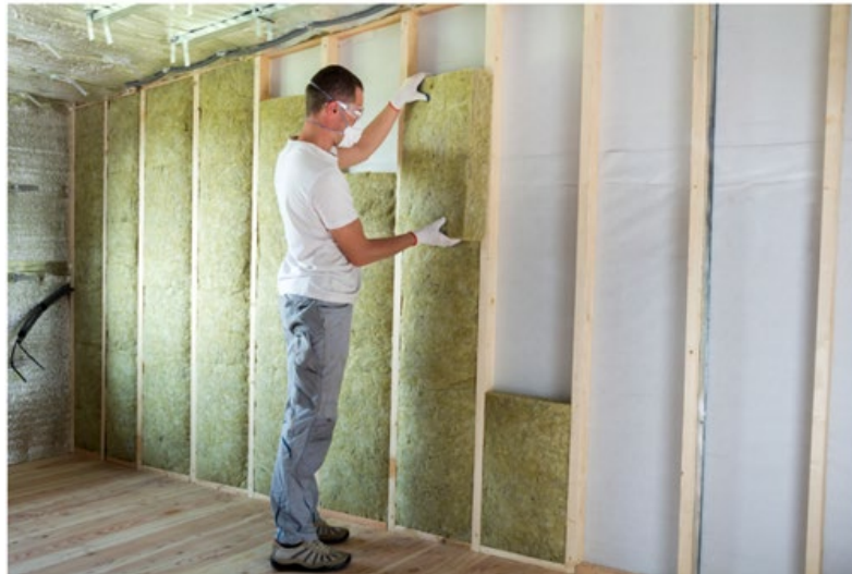
Figure 35. Isolation des murs par l'intérieur (technique 1)
