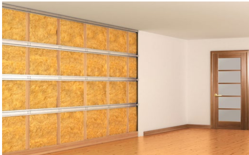
Figure 36. Isolation des murs par l'intérieur (technique 2)
