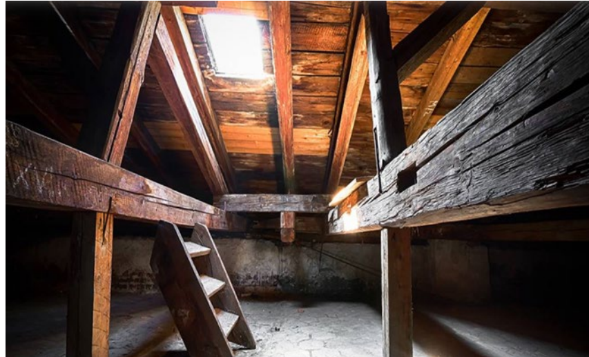
Figure 34. Zoom sur l'isolation des combles perdus
