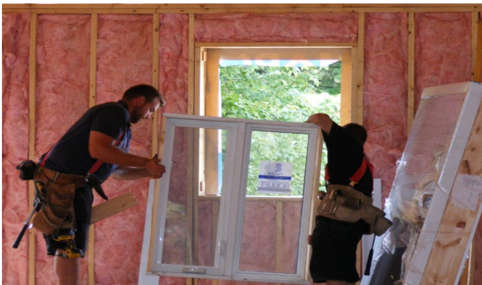
Figure 40. Emplacement de double fenêtre
