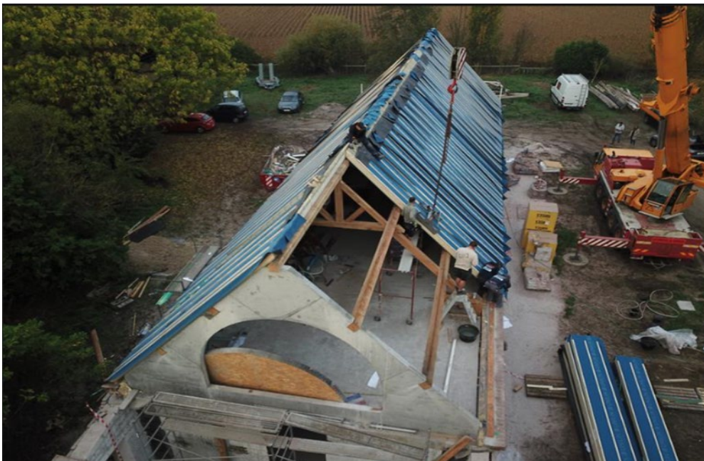
Figure 28. Caisson chevronné avec isolation acoustique
