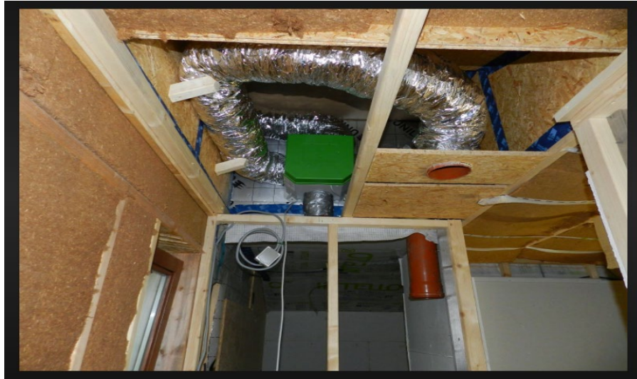
Figure 10. Système de renouvellement d'air dans un bâtiment
