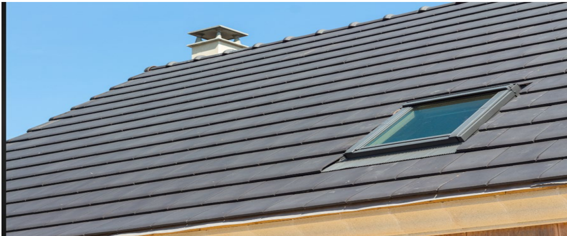
Figure 8. Toiture d'une maison non isolée.
