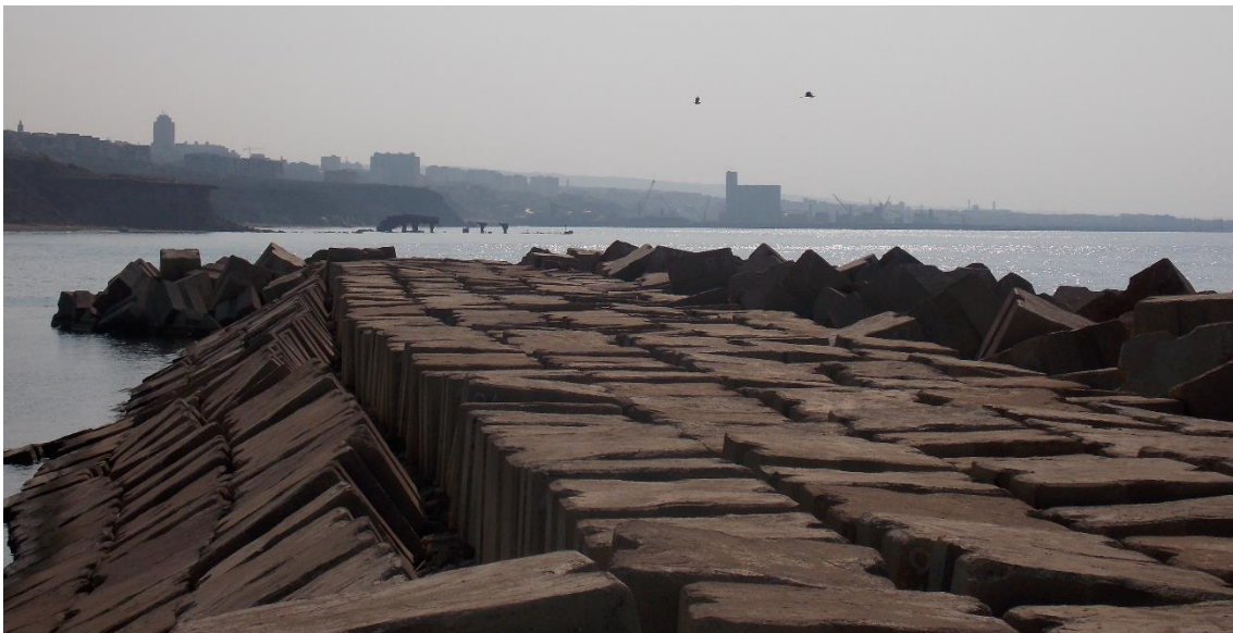
Figure 112: Digue de Sidi El Mejdoub
