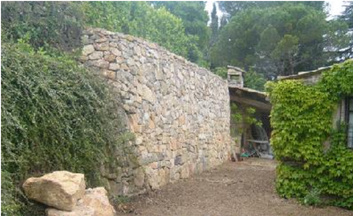
Figure 117: Mur de soutènements en pierre.
