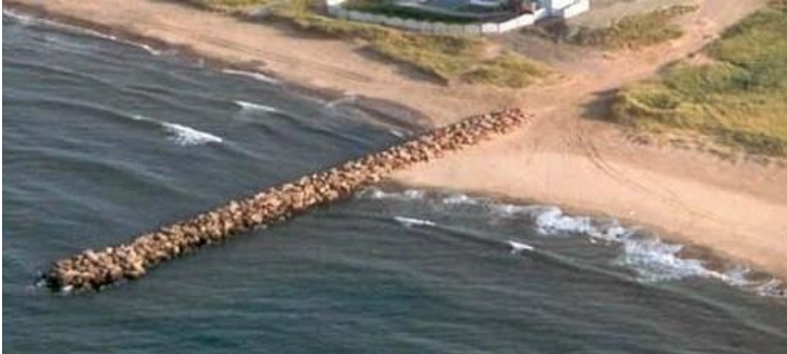
Figure 111: Procédé d'endiguement de la houle
