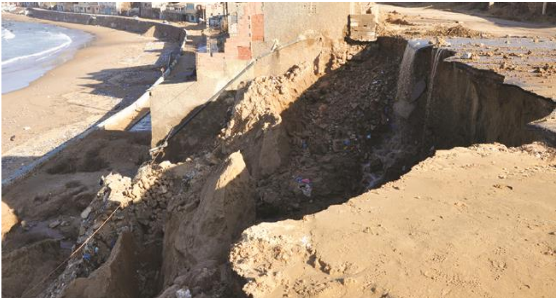
Figure 114: Glissement de terrain près de la plage de Kharrouba.
