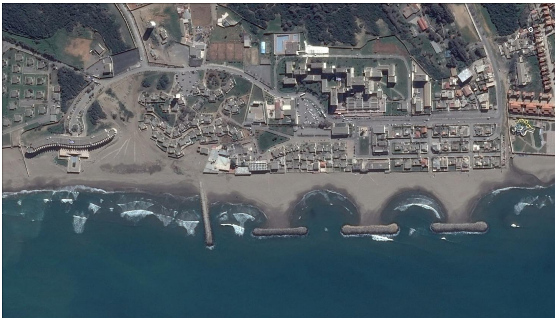
Figure 110: Répétitions des digues de protection des plages et d'élargissement à Zeralda.
