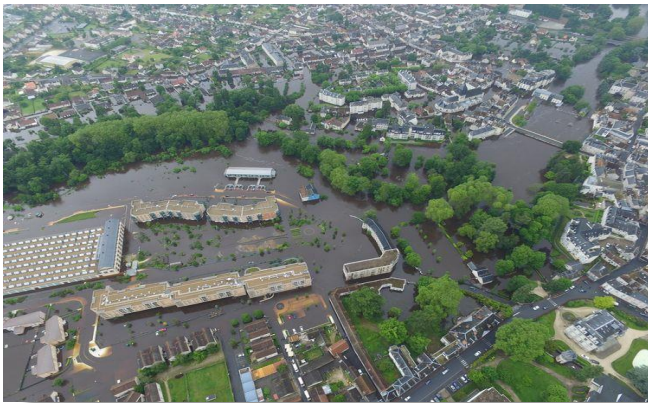
Figure 102 : photo aérienne du projet.
