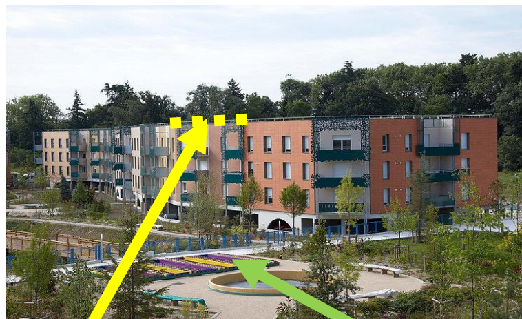
Figure 107 : les éléments de la façade.
