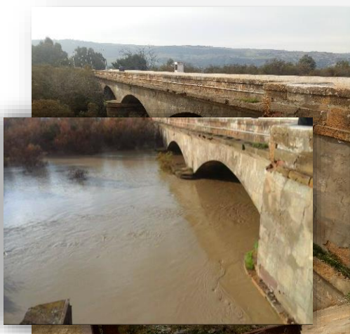
Figure 62 : la montée des eaux au niveau du pont (station de jaugeage) (4)
