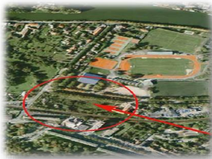
Figure 74 : Photo aérienne du projet
