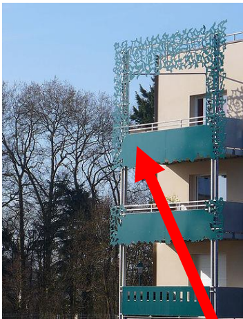
Figure 106 : les éléments de la façade.
