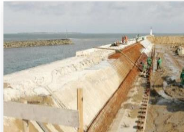
Figure22 : Confortement de la digue de la P
