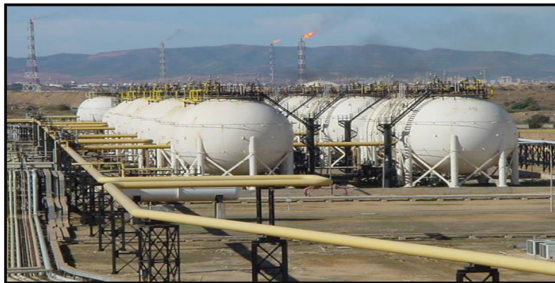
Figure I.3 Sphères de stockage.
