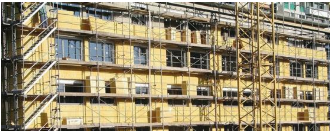
Photo 1 : Isolation thermique des bâtiments [7].
