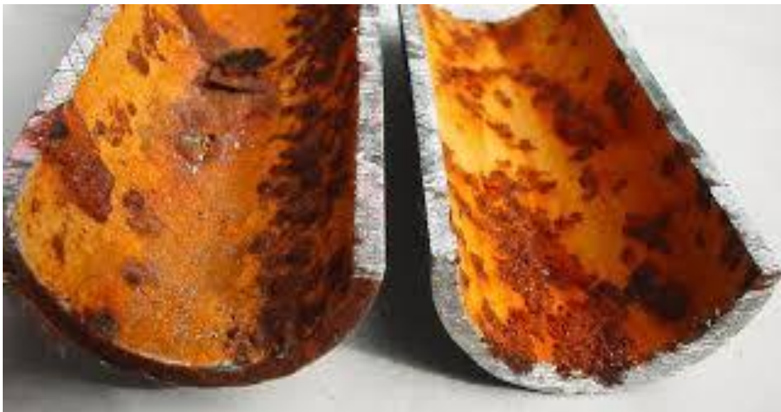
Figure I.3: Corrosion interne du métal.
