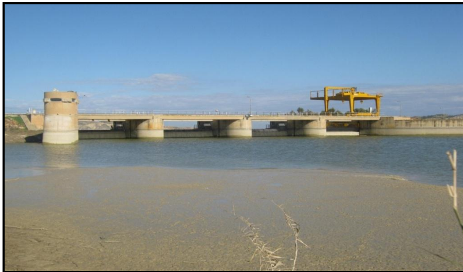
Figure I.29: La digue et la cuvette envasée du barrage de Fergoug (2012).
