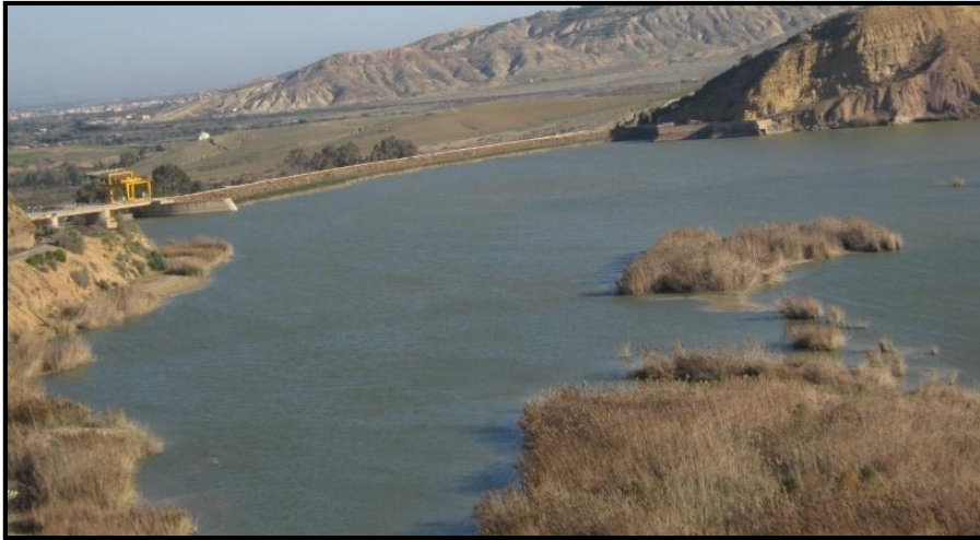
Figure I.28: Vue du barrage de Fergoug (2012).
