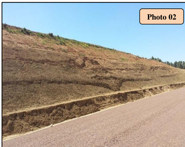
Photos 01-02-03 : Des signes de glissement au droit la couche d'argile.
