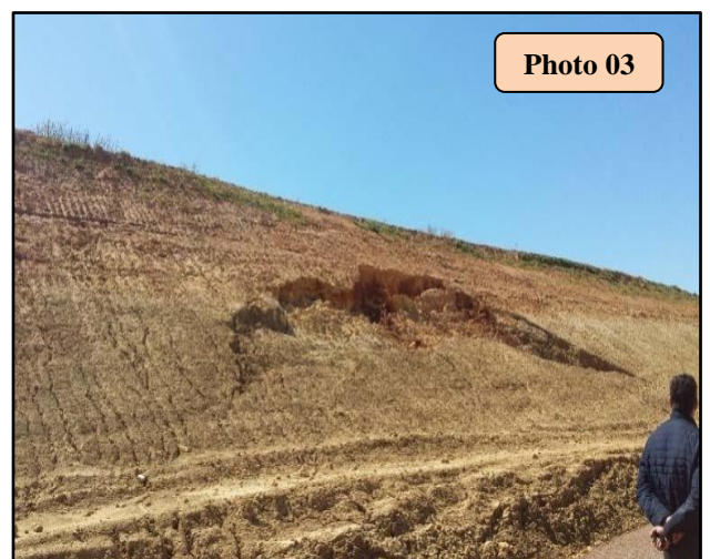
Photos 01-02-03 : Des signes de glissement au droit la couche d'argile.
