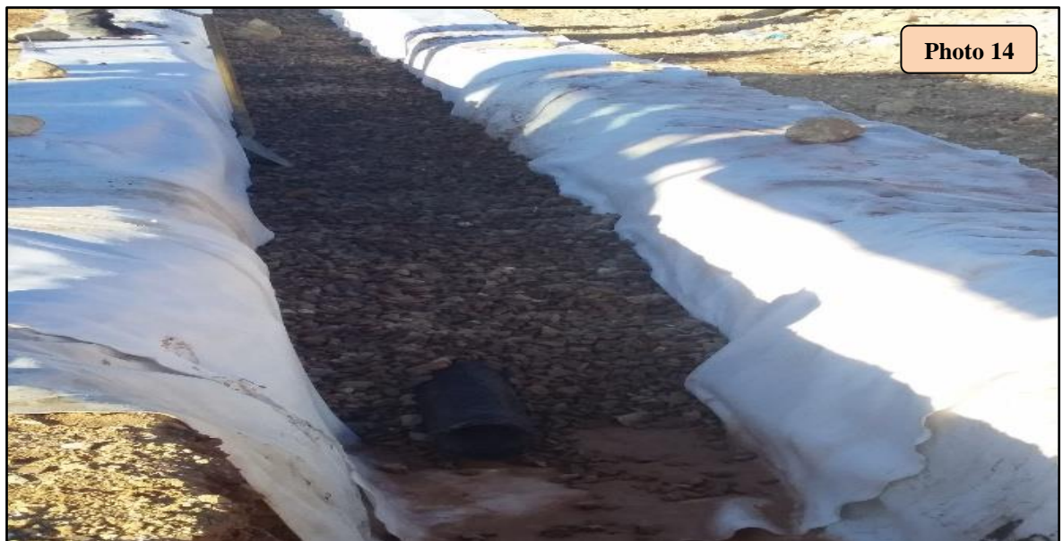
Photos 10-11-12-13-14 : Réalisation du drainage profond.
