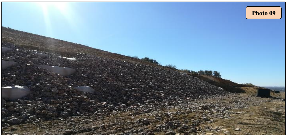
Photos 08-09 : Reprofilage des talus dégradés (1er talus), et réalisation des redans réguliers de dimension 1.5V/2H
