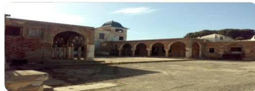
Le palais du bey. /Source : Auteur2017
