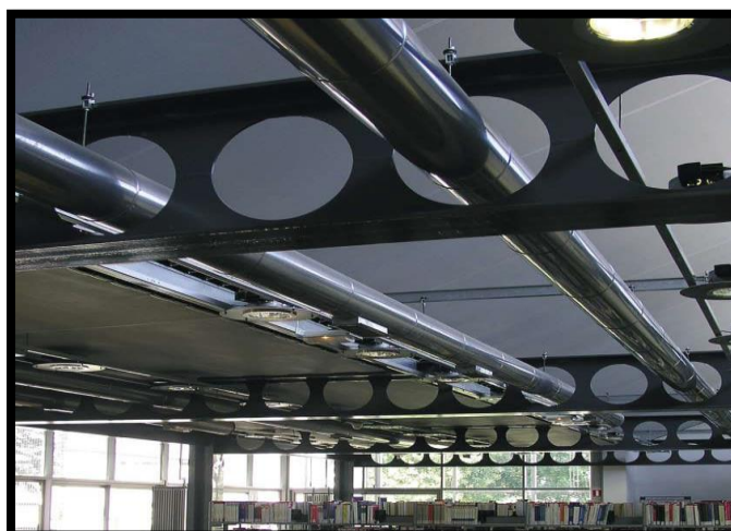
Figure IV.13: poutre alvéolaire (ArchiExpo).
