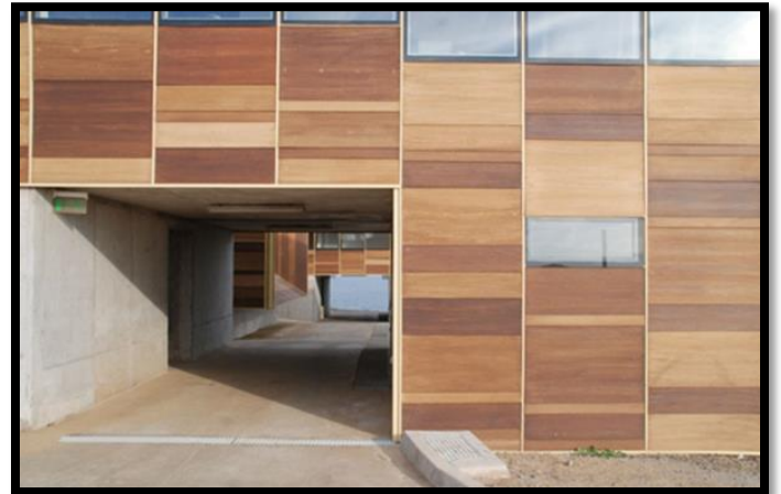
Figure II.43: vue de l'intérieur.
