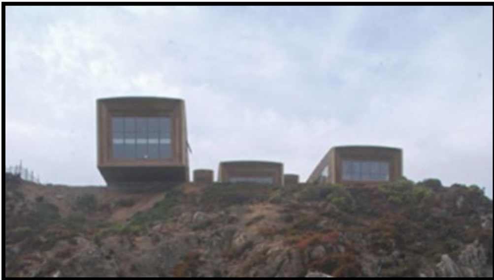
Figure II.44 : vue de la façade sud.(Archdaily 2010, disponible sur: https://www.archdaily.com/428528/coastal-marine-research-station-puc ).
