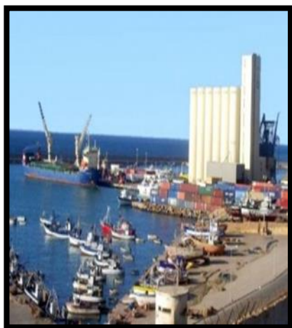
Figure III.5 : port de marchandises de Mostaganem. ( https://www.aliqtsadia.com/fr/2021/04/20/por )
