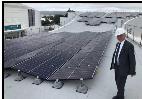
FigureII.51 : photo des panneaux solaires sur la toiture du bâtiment. (Ouest France, disponible sur : https://www.ouest-france.fr/bretagne/brest-29200/en-images-brest-oceanopolis-installe-des-panneaux-solaires-avant-son-30e-anniversaire-6539595 ).
