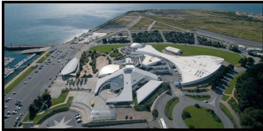
FigureII.47 : vue de dessus sur le bâtiment. (Nageenmer 2018, disponible sur : https://nageenmer.files.wordpress.com/2018/11/radebrest_occ3a9anopolis.jpg?w=684&h=458 ).
