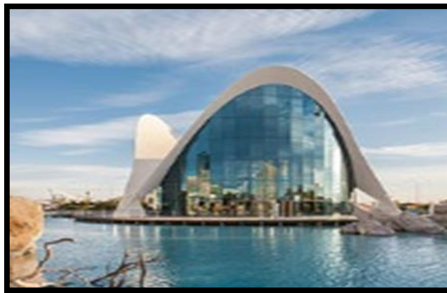
FigureII.14 : vue de profil sur le bâtiment d'entrée. (Diliff2007, Wikipédia).
