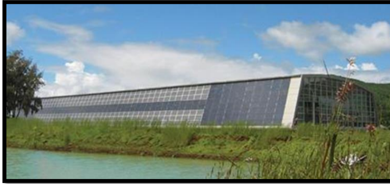
Figure II.23 : vue sur la façade avec les plaques photovoltaïques. (Ramprasad Nadu, disponible sur : https://m.blog.naver.com/PostView.naver?isHttpsRedirect=true&blogId=multiprayer&logNo=100177556754 ).
