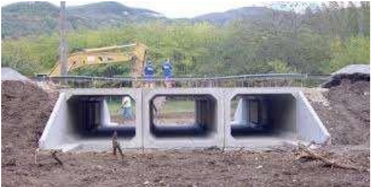
Figure VII.3 Dalot de trois ouvertures
