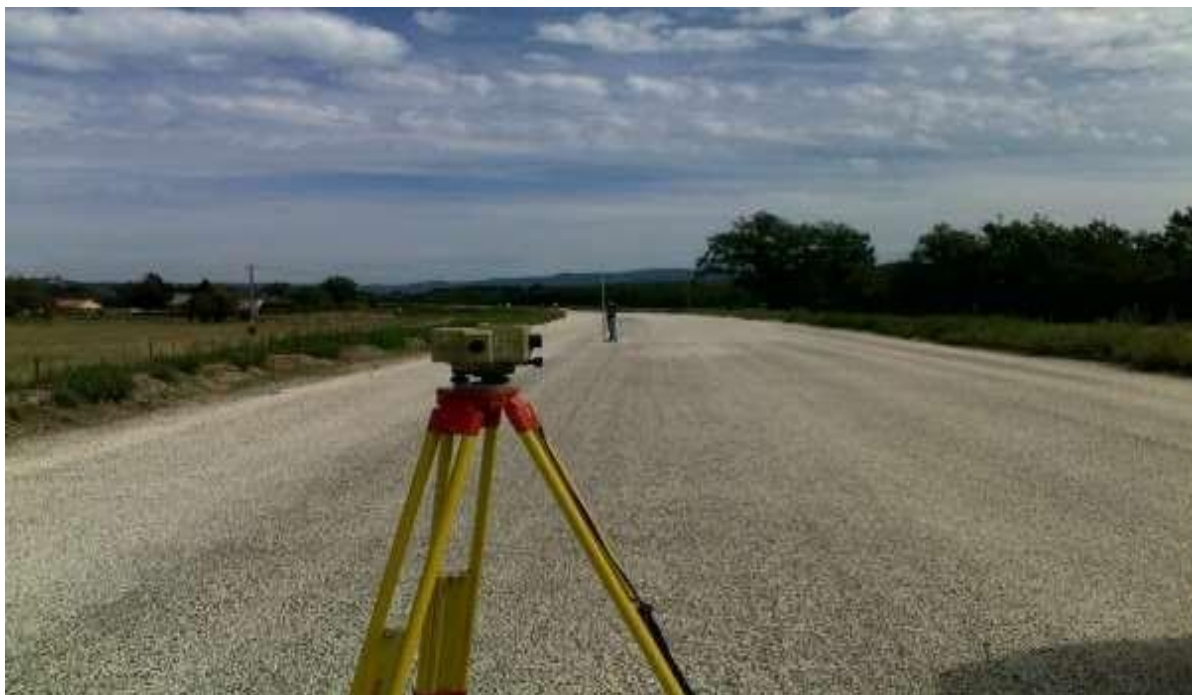
Figure VI. 1 Piquetage et nivellement d'un point
