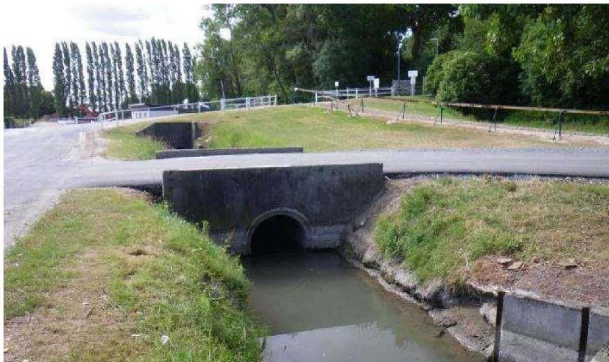
Figure VII.4 Ouvrage busé
