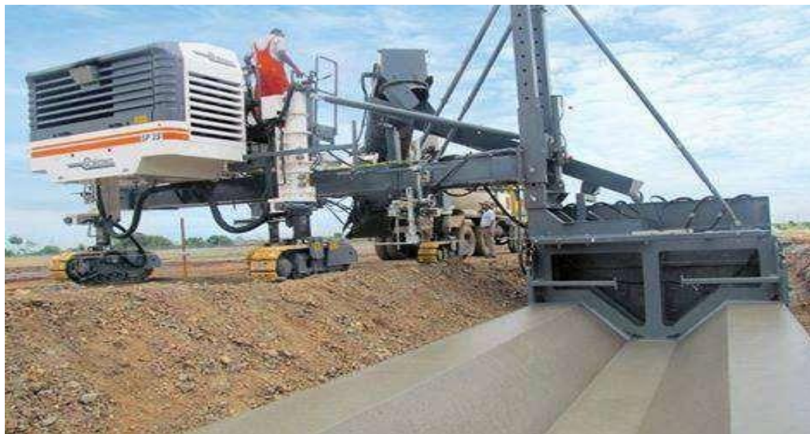
Figure VII.2 Machine a coffrage glissant pour réalisation des fossés
