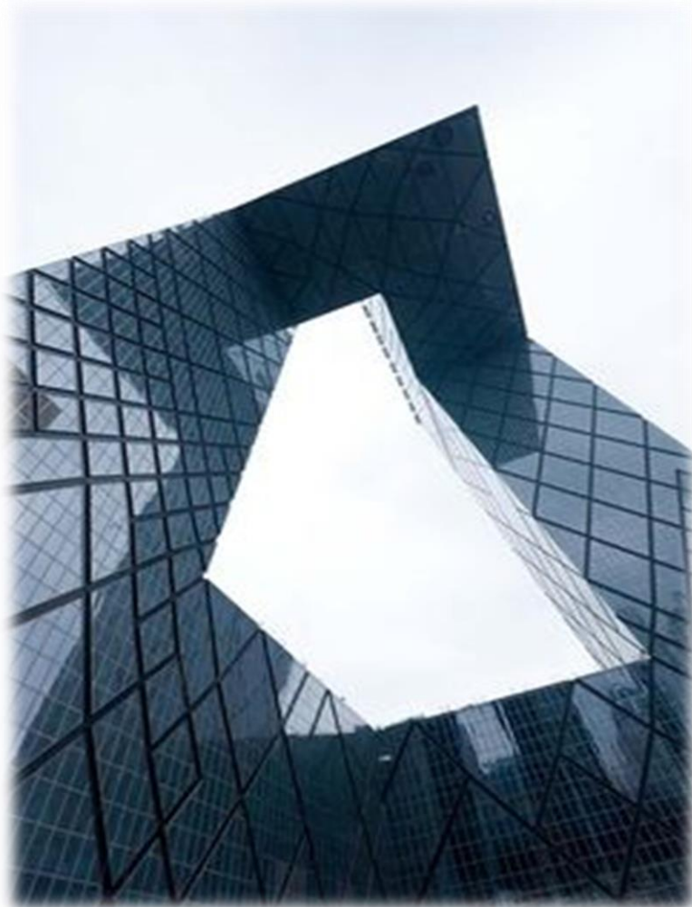
Figure N° : Façade en verre du bâtiment
