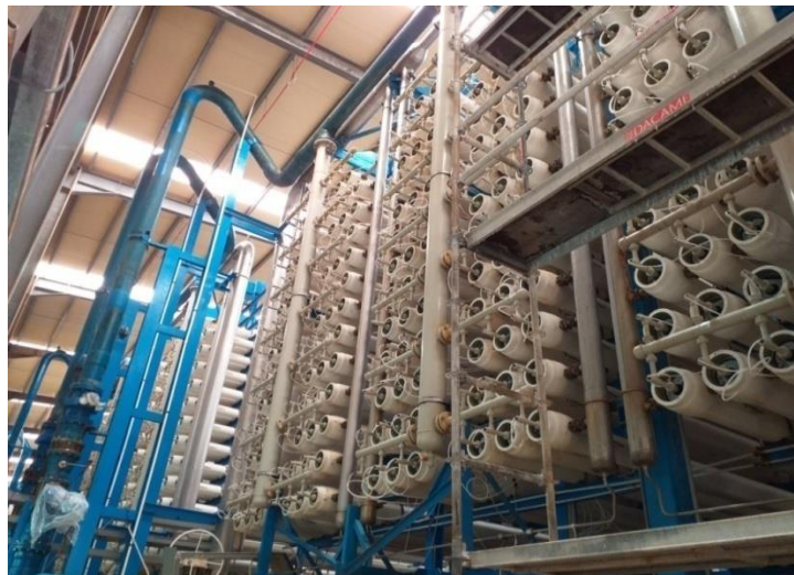
Photo III.6 : Les tubes de pression
