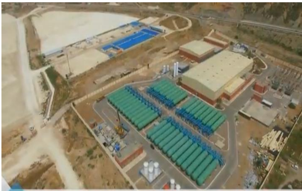
Photo III.1 : Vue générale sur la station de Mostaganem
