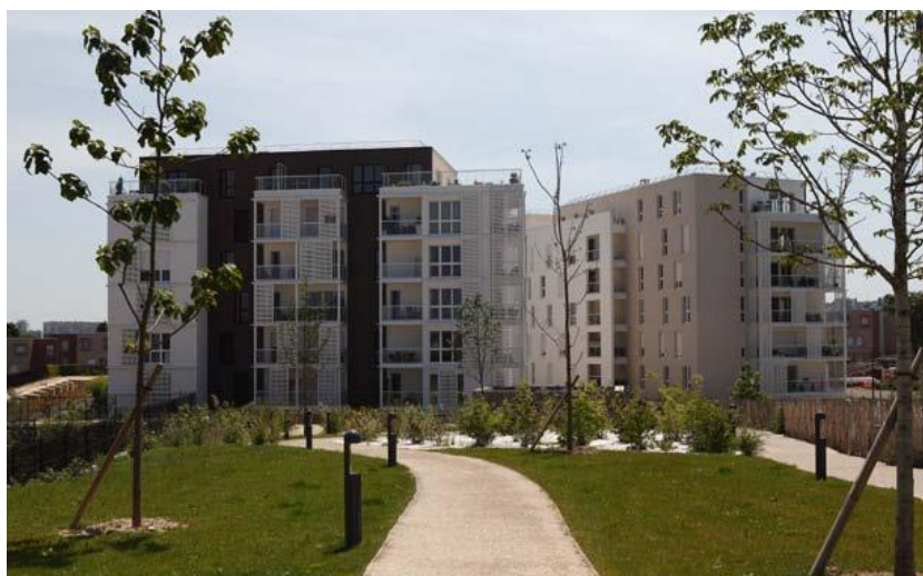
Figure 91 : photo d'illustration du l'immeuble Horizon des Bastions
