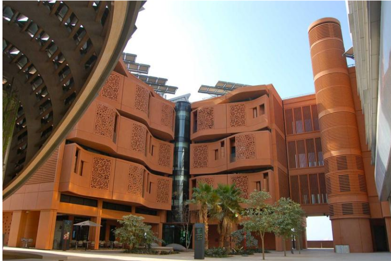
Figure 61 : photo d'illustration des bâtiments résidentiels
