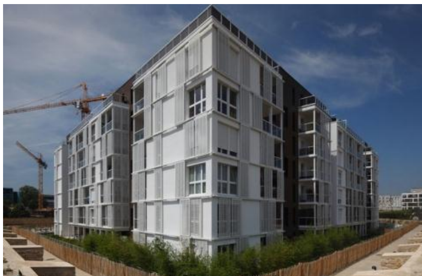
Figure 92 : photo d'illustration du l'immeuble Horizon des Bastions
