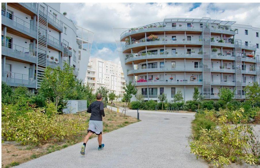
Figure 107 : photo d'illustration des courtines
