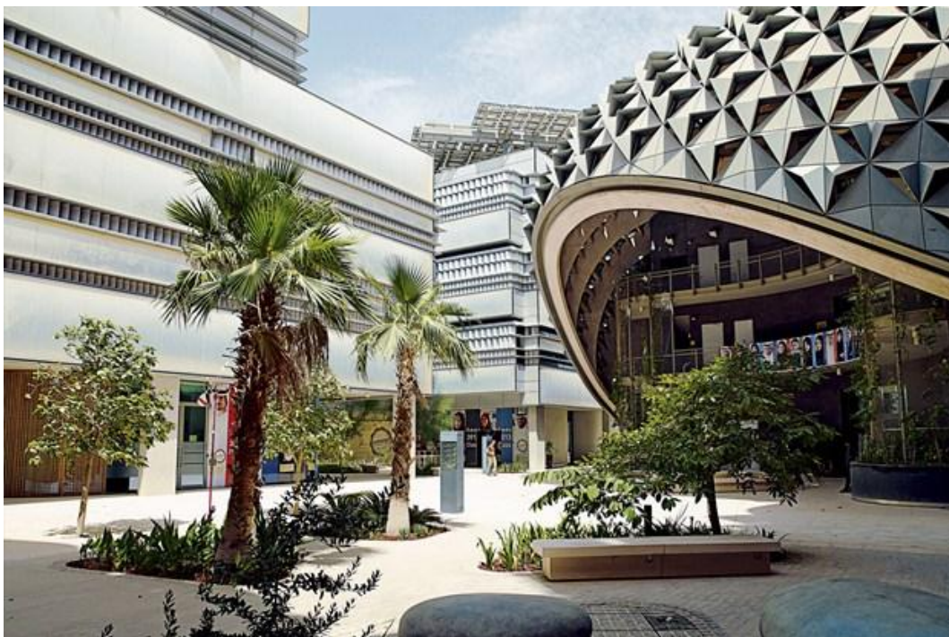
Figure 70 : photo d'illustration des cours internes
