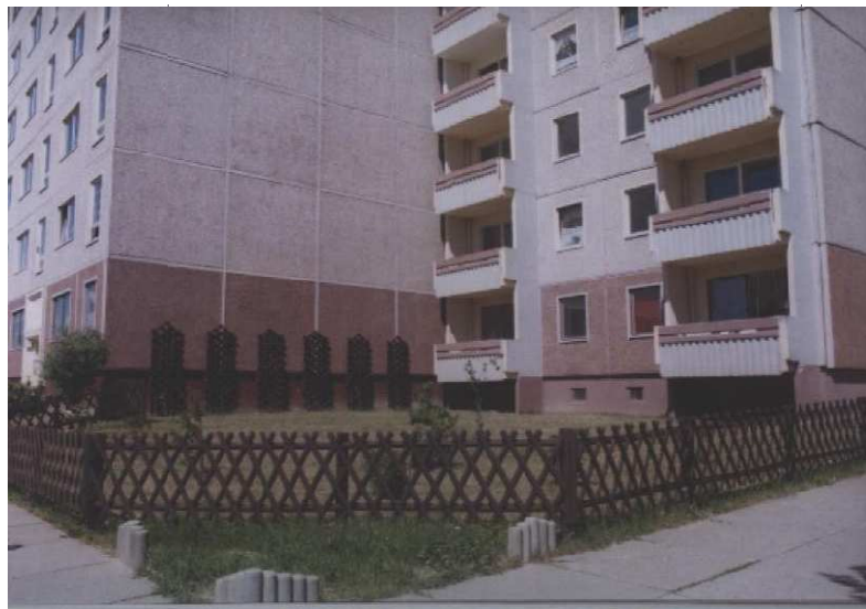
Figure 42: Espace vert dont les limites sont matérialisées par une clôture Source : « Cliche AEK. SMAIR »
