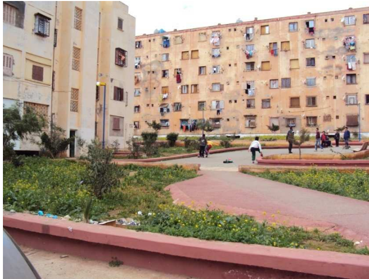
Photographie 20: Espace de détente investi en terrain de football par les jeunes du quartier Source : Cliché de l'auteur, 2010
