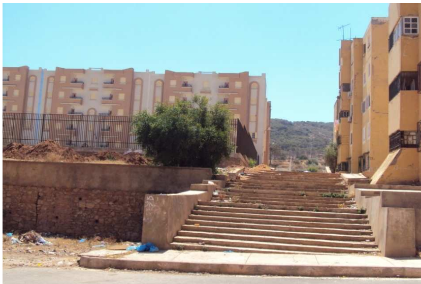
Photographie 38: Escalier raccordant la partie haute à la partie basse de la cité Source: L'auteur, 2010
