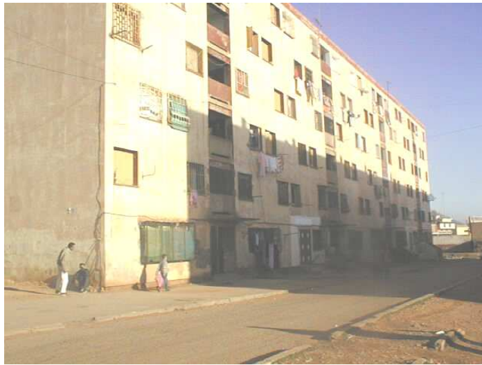
Photographie 06: Absence de structuration des espaces extérieurs, 1998 Source : Projet de restructuration urbaine et réhabilitation du cadre bâti – OPGI Oran
