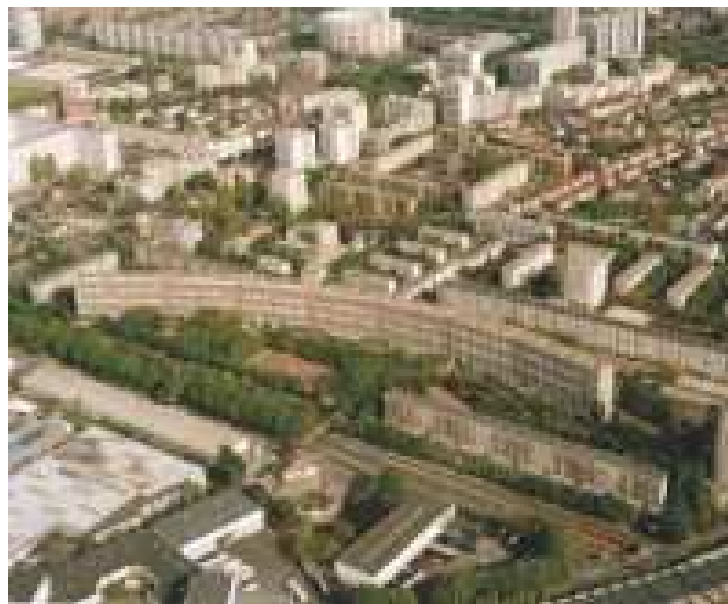
Figure 34: Vue générale du quartier Source: http:// i.ville.gouv.fr
