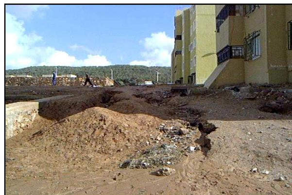
Photographie 34, 35: Absence de système de drainage des eaux pluviales Source : BET- AUA-SA
