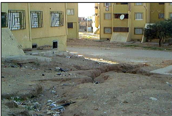
Photographie 34, 35: Absence de système de drainage des eaux pluviales Source : BET- AUA-SA
