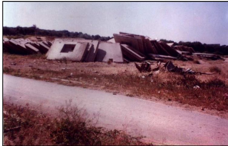
Photographie 29: Eléments préfabriqués abandonnés après la réalisation des logements Source : BET- AUA-SA
