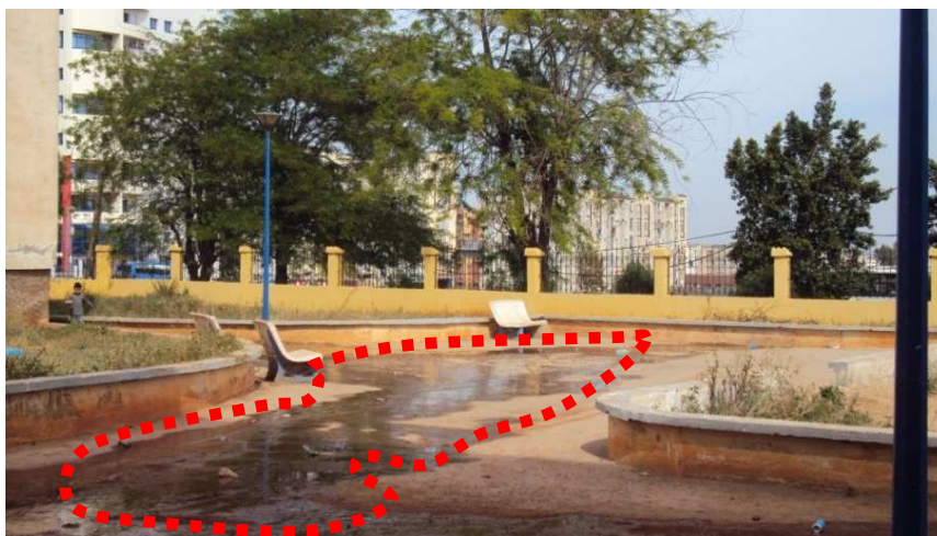
Photographie 25: Espace extérieur impraticable en période pluvieuse
