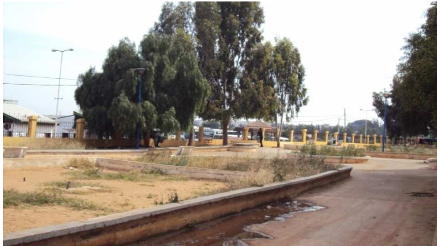
Photographie 19: Espace mal entretenu attendant au mur de clôture de la cité Source : Cliché de l'auteur, 2010
