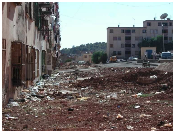
Photographie 07: Espaces immédiats aux immeubles abandonnés Source : Projet de restructuration urbaine et réhabilitation du cadre bâti – OPGI Oran
