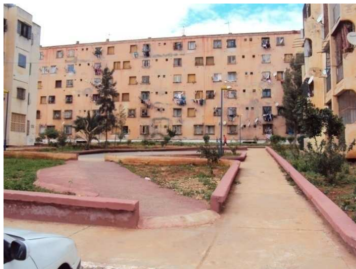
Photographie 23: Cheminements traversants les espaces verts Source : Cliché de l'auteur, 2010
