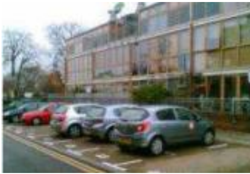
Figure 65: les parkings à BEDZED pluiés
